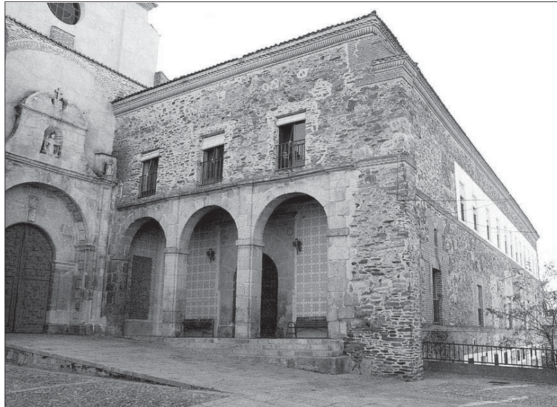
Imagen de la residencia municipal, donde se han encontrado algunas deficiencias
