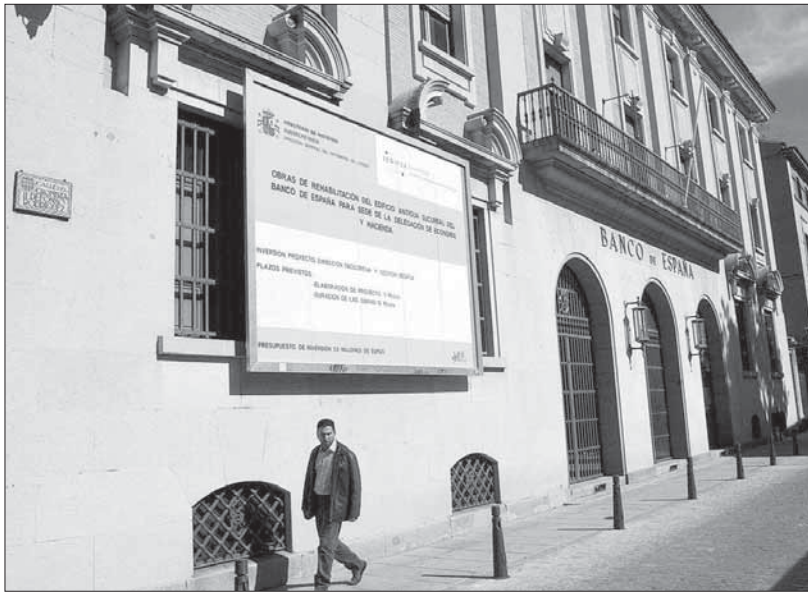
Las obras en el Banco de España comenzarán a principios de 2006 y durarán dos años
