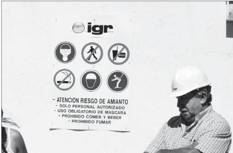
En la entrada de la zona de actuación se informa de las medidas de seguridad exigidas
