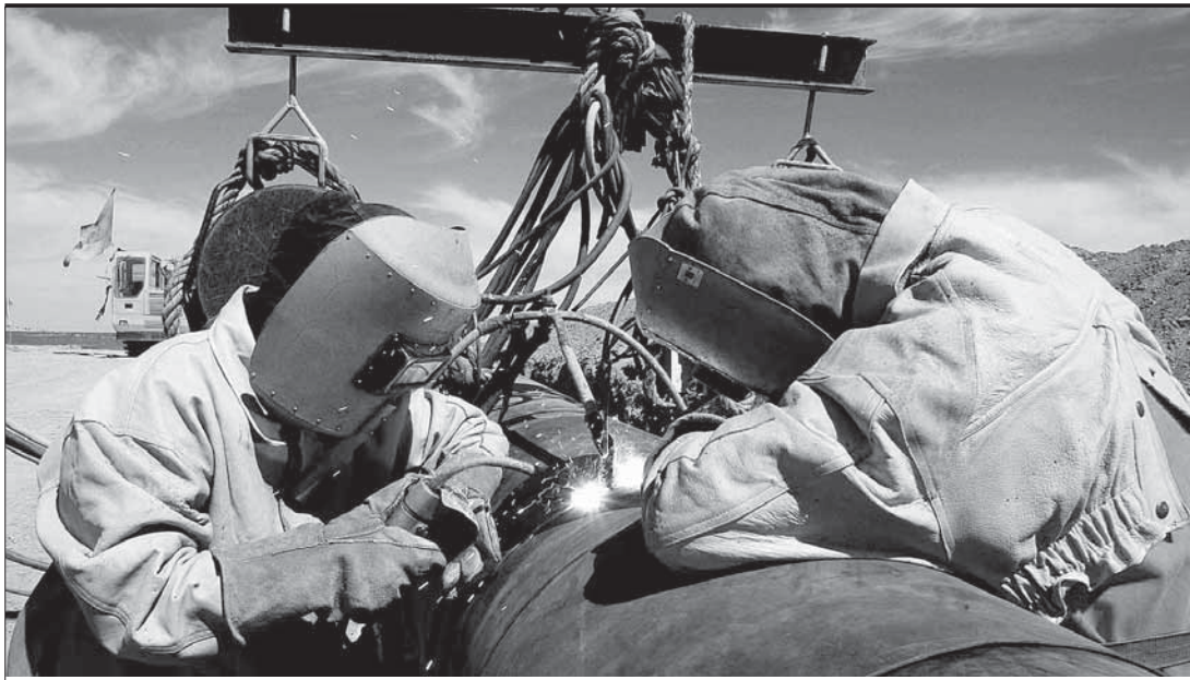
Las mujeres trabajan en el oleoducto más complicado de China. El Gobierno chino intenta culminar la red de oleoductos por el país. En la imagen, dos empleadas sueldan un oleoducto en el borde del desierto Luobubu, en la región del noroeste chino de Xinjiang Uigur. El equipo de construcción, exclusivamente femenino, consta de una docena de mujeres que tiene la misión de colocar una parte del oleoducto de 1.900 kilómetros de longitud que se extiende a través de las regiones geográficamente más difíciles del norte de China. / FOTO: EFE
