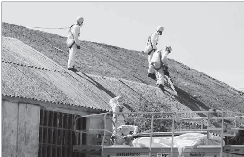
Trabajos realizados ayer para retirar placas de fibrocemento con contenido de amianto
