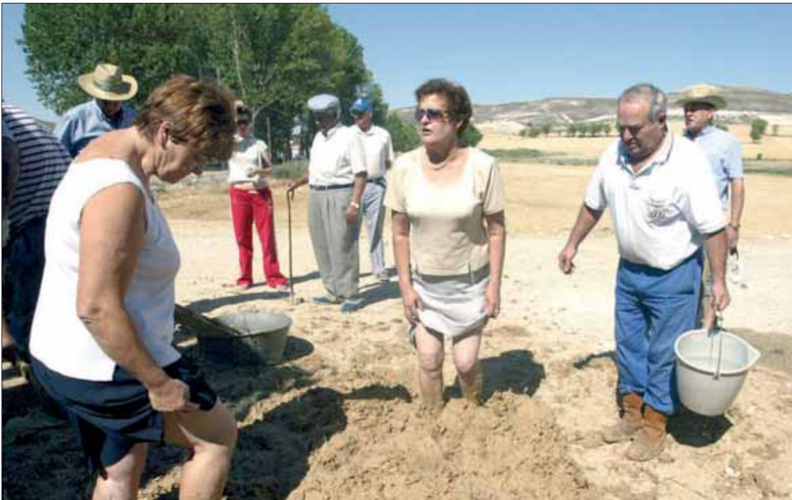
Dos mujeres pisan la masa que mezcla el barro con la paja para poder elaborar posteriormente los ladrillos de adobe
