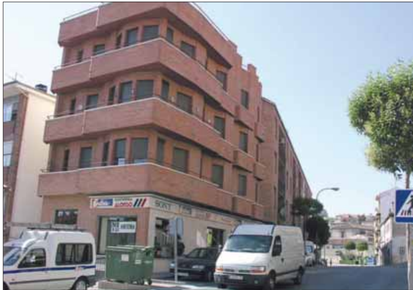
Edificio en el que Vodafone pretendía la instalación de la estación de telefonía móvil
