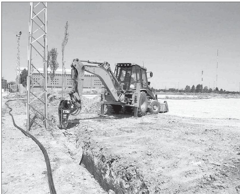
Una máquina excavadora, trabajando ayer en el solar que ocupará el campo de hierba artificial // JUAN MARTÍN
