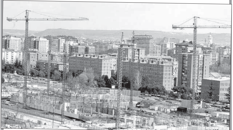
El 50 por ciento de la estructura. El pasado mes de febrero, las empresas adjudicatarias FCC y Collosa ya habían construido el 50 por ciento de la estructura del edificio que se levanta en Villa del Prado de Valladolid. Ya se estaba levantando la primera planta de las cuatro que tendrá. / FOTO: ICAL
