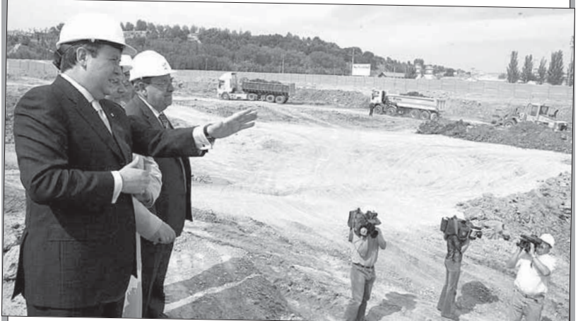
Movimiento de tierras. El presidente de las Cortes visitó las obras en junio del año pasado, momento en el que se estaba realizando el movimiento de tierras con la extracción de 30.000 metros cúbicos, parte de la cual se utilizó posteriormente en el talud del edificio. / FOTO: RUBÉN CACHO (ICAL)
