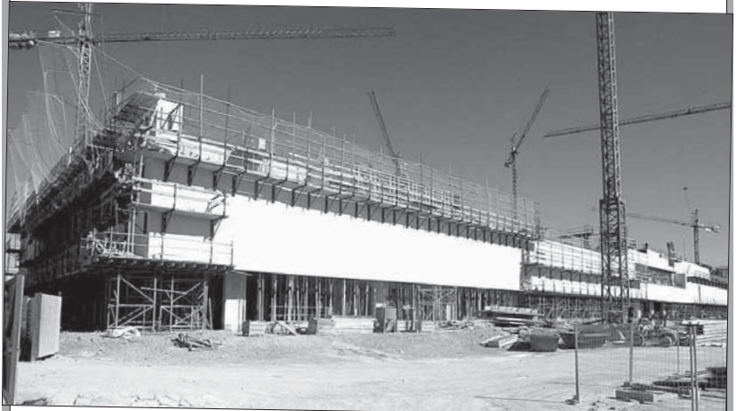
El edificio se levanta. Esta misma semana la estructura del edificio ya levanta varias plantas y en la primera quincena de septiembre se instalará la cúpula del futuro hemiciclo, que luego será revestida de alabastro. Los obras continúan durante el mes de agosto a buen ritmo. / FOTO: RUBÉN CACHO (ICAL)
