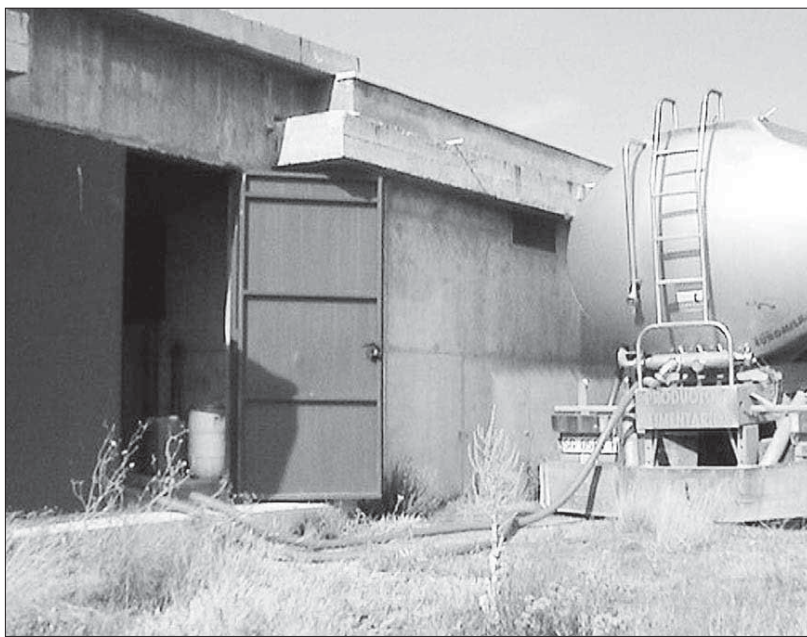
Un camión cisterna suministraba ayer agua al depósito de Cerezo de Abajo
