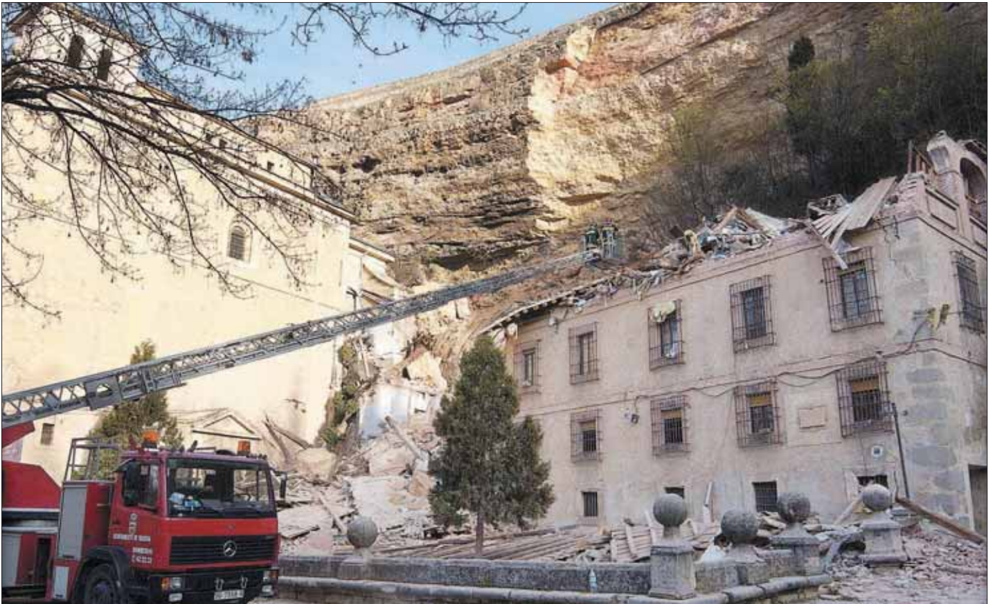
Los bomberos trabajaron a lo largo de toda la jornada para evitar que se produzcan nuevos desprendimientos que afectarían directamente al templo
