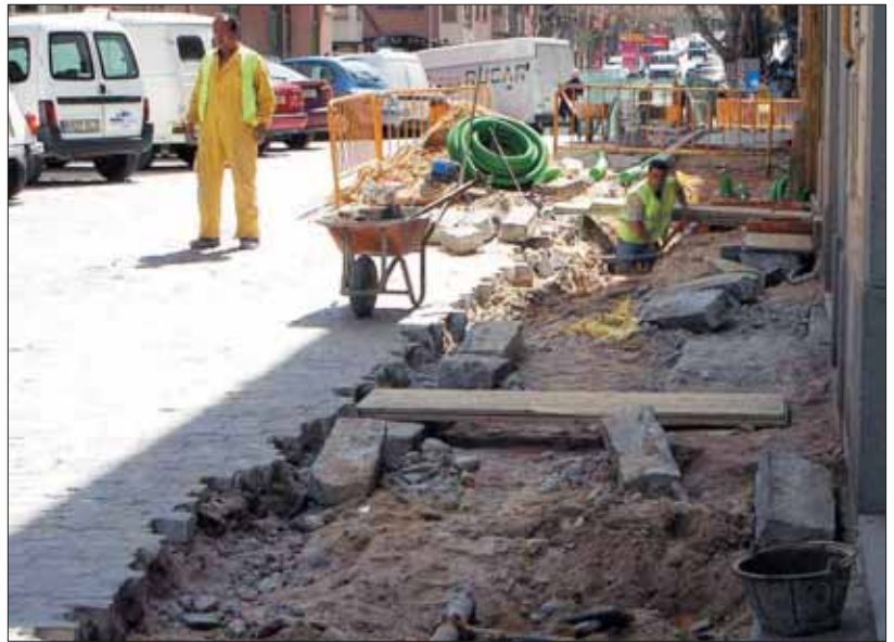
Imagen de las obras, ayer, que se ejecutan en Escultor Marinas para la ampliación de las aceras. KAMARERO
