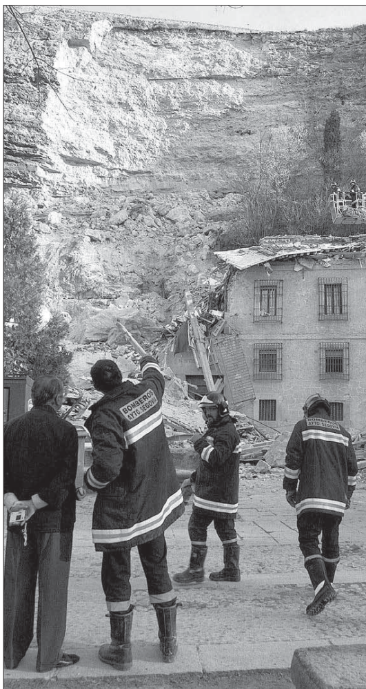
Las rocas destruyeron más de 200 metros cuadrados del inmueble J. MARTÍN
