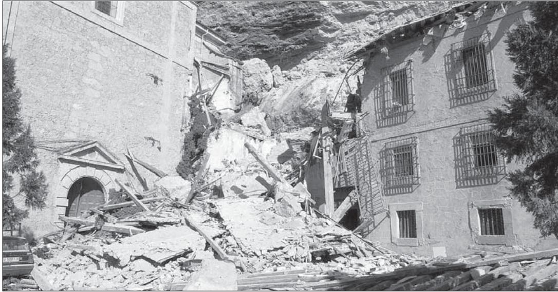
El desplome de las rocas sobre la casa rectoral evidenció la existencia de una gran grieta que puede provocar más derrumbamientos J.MARTIN
