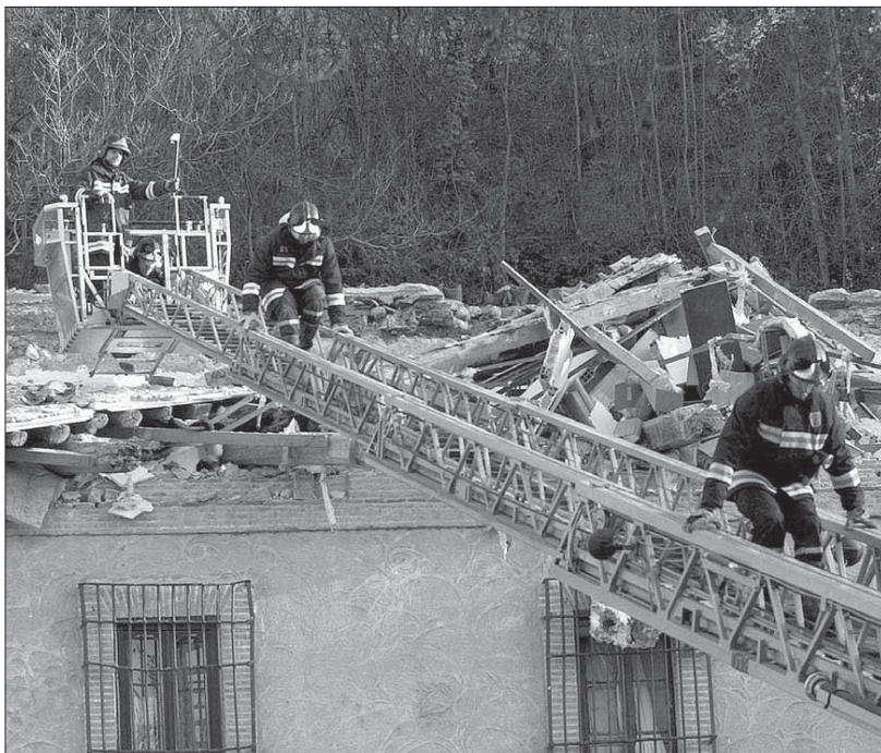
Los bomberos emplearon la autoescala para evaluar los daños en el edificio
