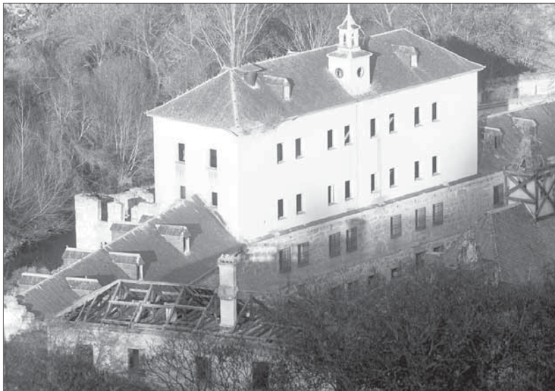
La restauración de la Casa de la Moneda de Segovia permanece a la espera de la firma del convenio
