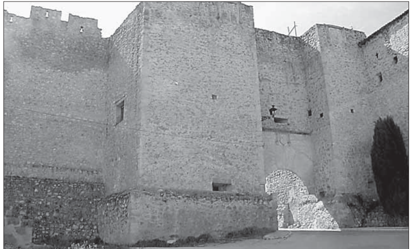
La villa conserva actualmente tres cuartas partes de sus murallas primitivas
