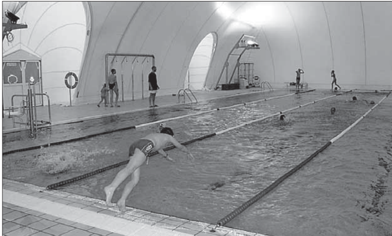
Interior de la piscina climatizada de Cuéllar
