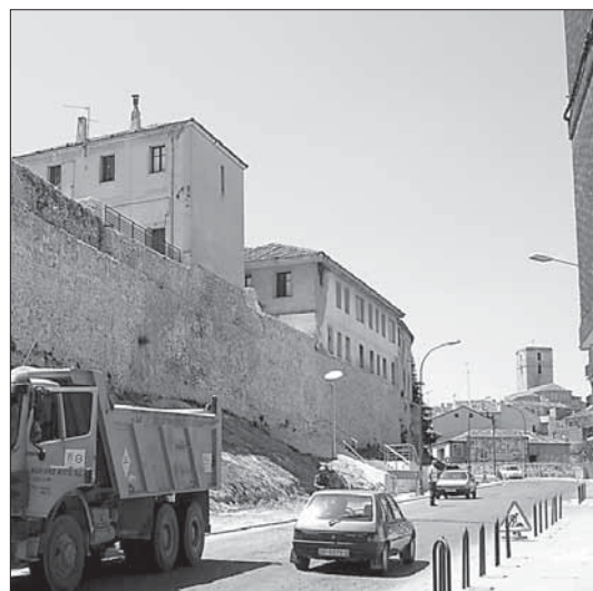
Tramo de la calle Nueva que se acondicionará en la primera fase
