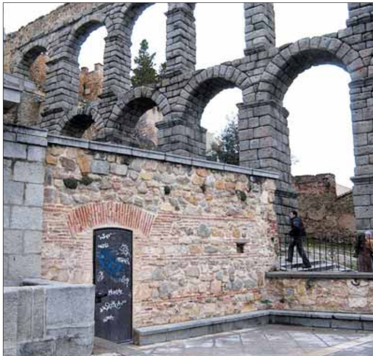
Fachada de la capilla de Santa Columba, a escasos metros del Acueducto
