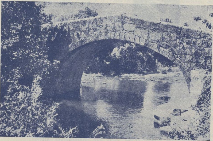
Puente de Santihervás
