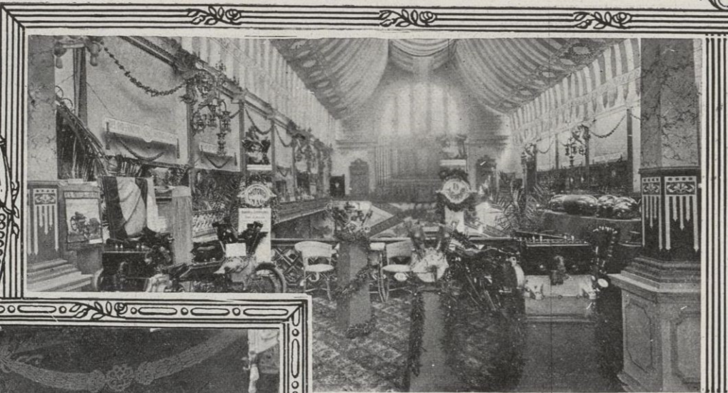
Vista de conjunto de las galerías altas
