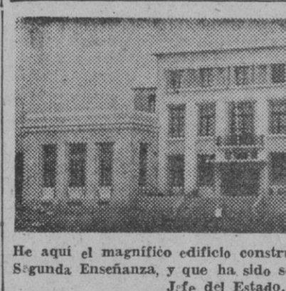
He aquí el magnífico edificio construido en La Coruña para Instituto de Segunda Enseñanza...
