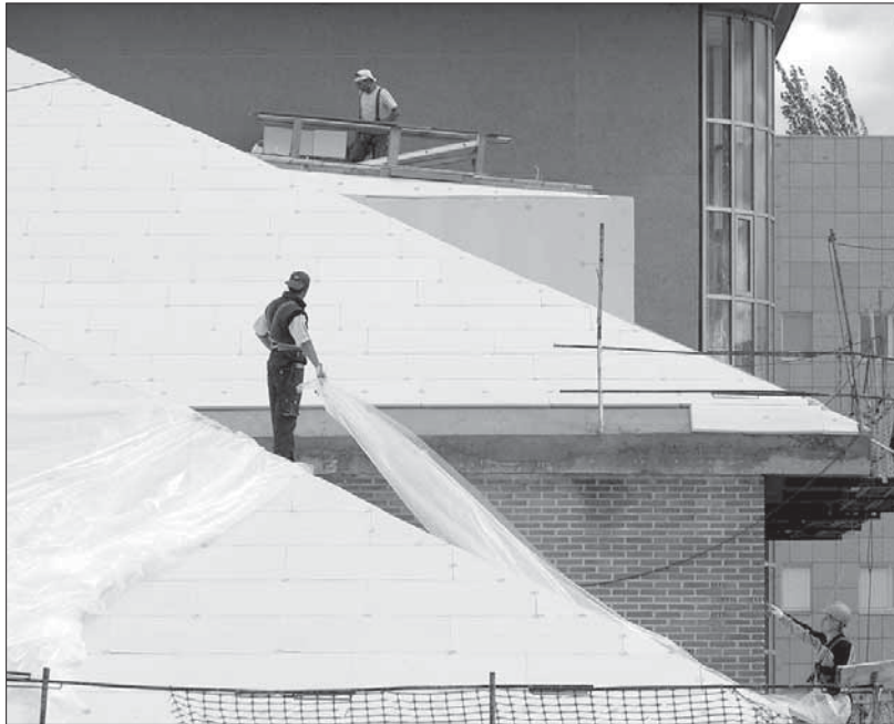
Los trabajadores colocaban ayer plásticos sobre la cubierta del Hospital General
