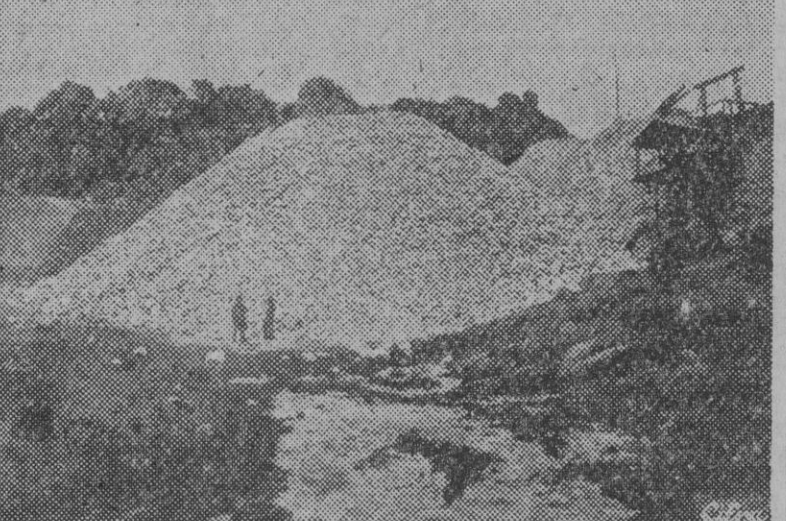
Con las piedras extraídas de las rocas vaciadas para construir la cripta, y que forman ya verdaderos montes, en el Valle de los Caídos, se construirá el Monasterio. (Foto Cifra)
