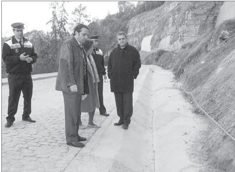
Arahuetes inspeccionó el pasado mes de diciembre las primeras obras ejecutadas por la Junta PENALOSA
