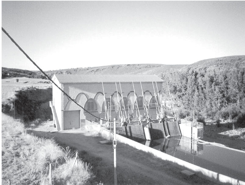
Las minicentrales, como esta de Pereluela, en Zamora, tienen una potencia máxima de 50 MW
