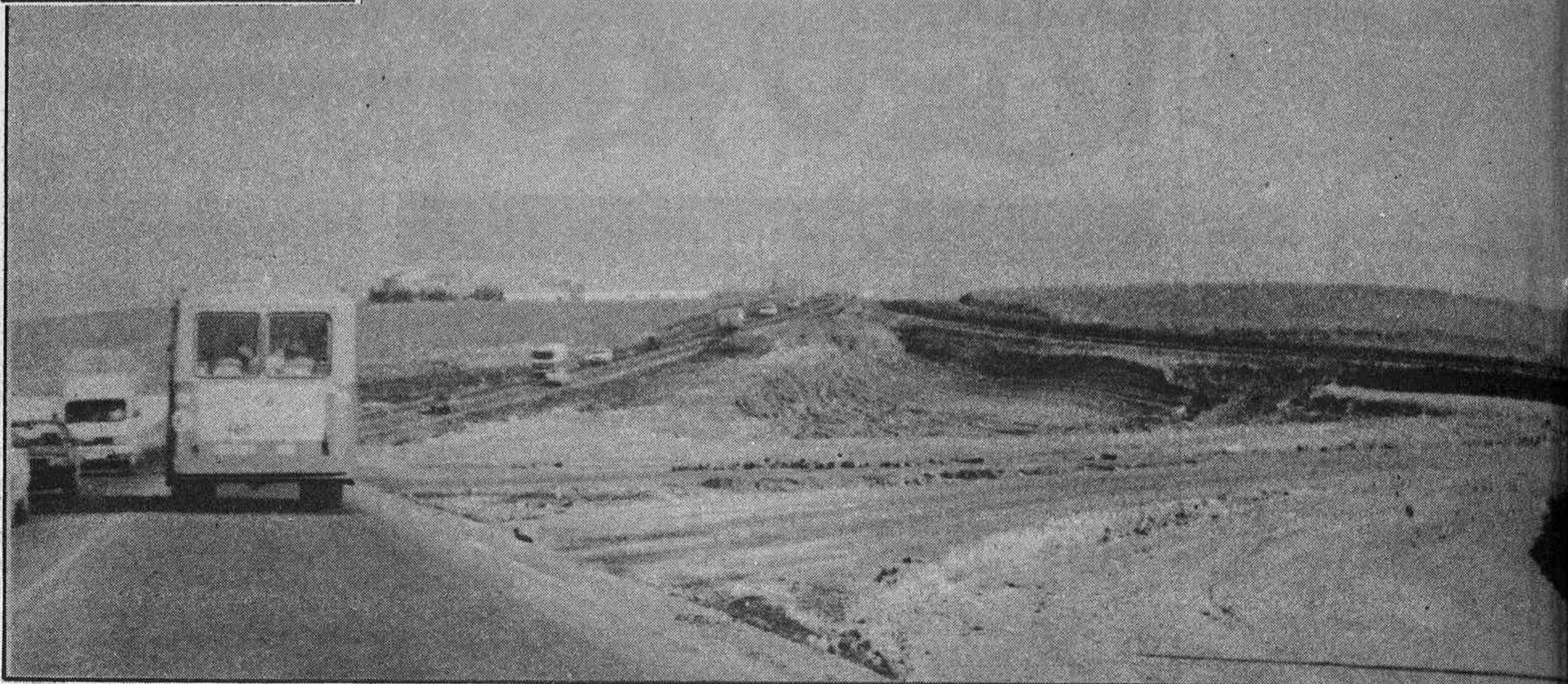
En obras ya, el tramo que va de Leganés a Fuenlabrada, y que unirá otras dos autovías, la que irá de las carreteras de Andalucía y Extremadura, y otra que va por Móstoles, Fuenlabrada y Pinto.
