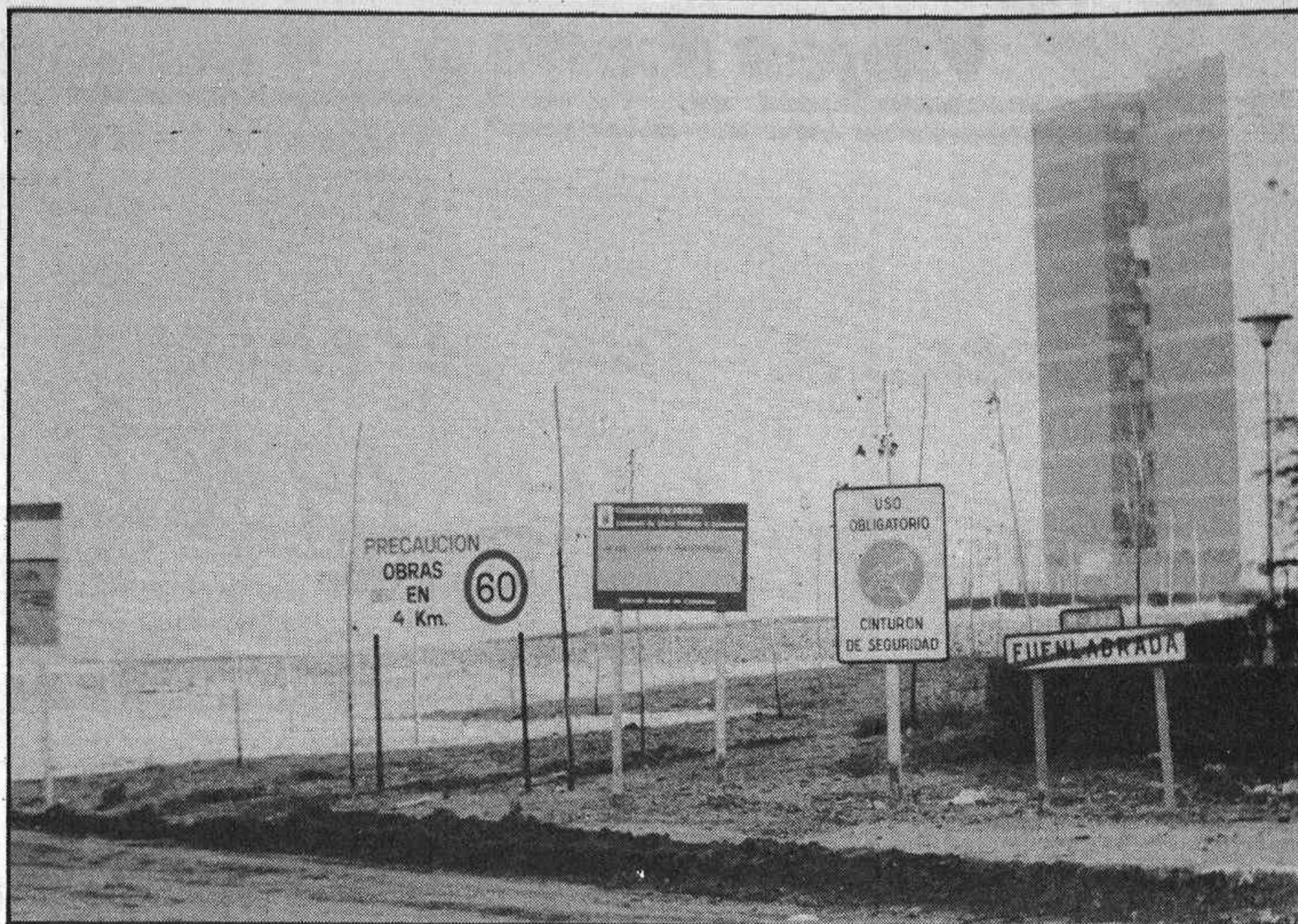
A la salida de Fuenlabra y en la carretera que va a Leganés es uno de los puntos negros con más accidentes mortales al año de todas las carreteras de la zona sur de Madrid.
