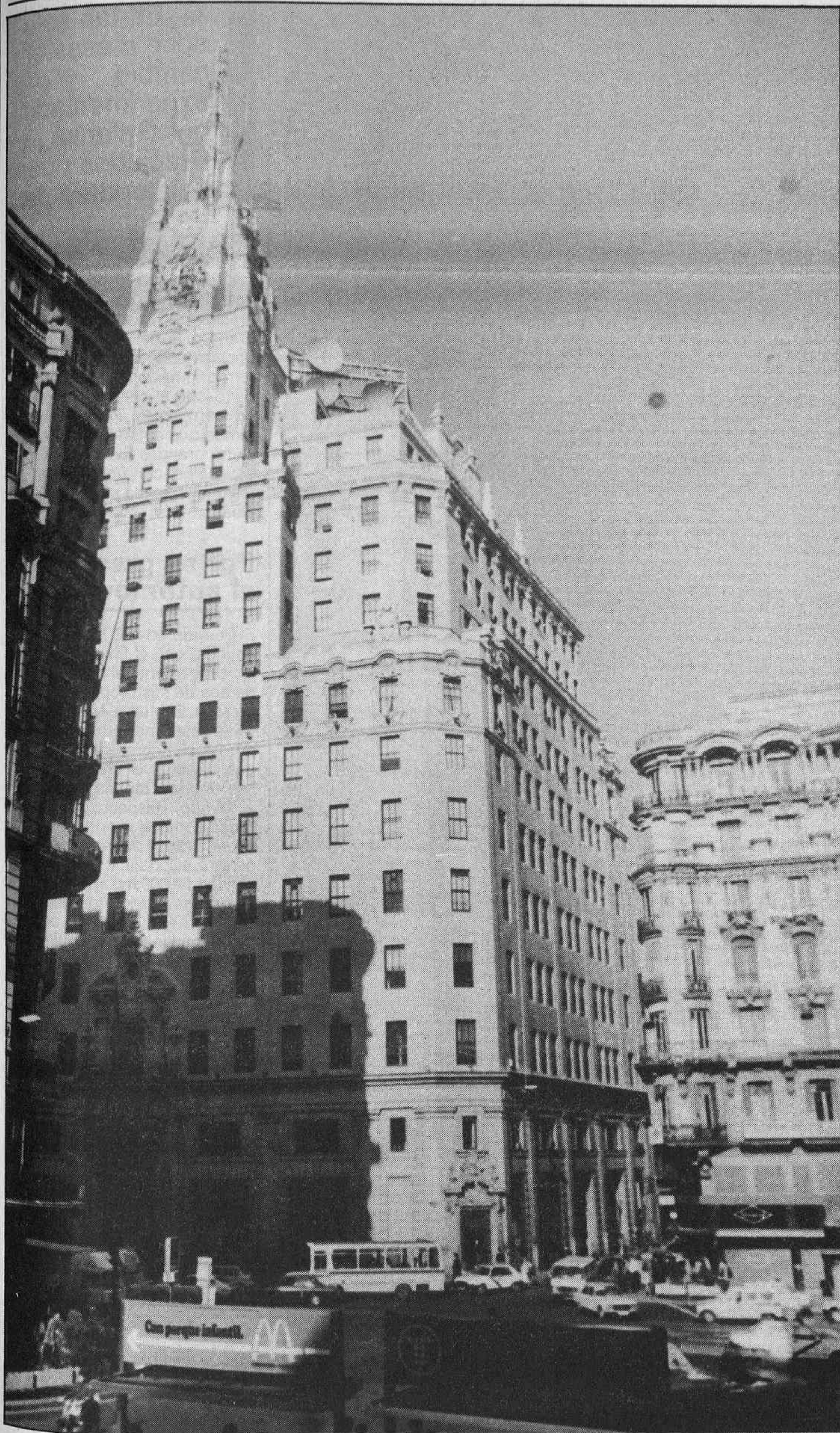
El edificio de la Telefónica, en plena Gran Vía madrileña.
