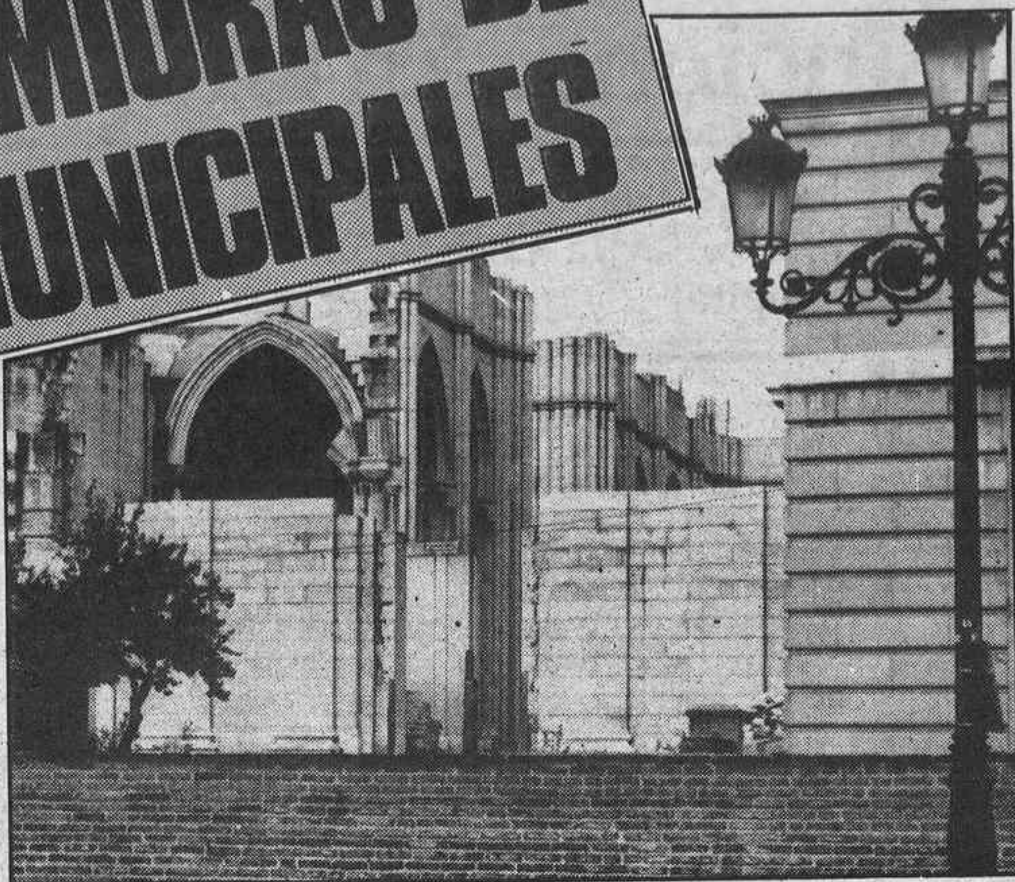
Desde la calle de Bailén, esta imagen desalentadora de la obra inacabada
