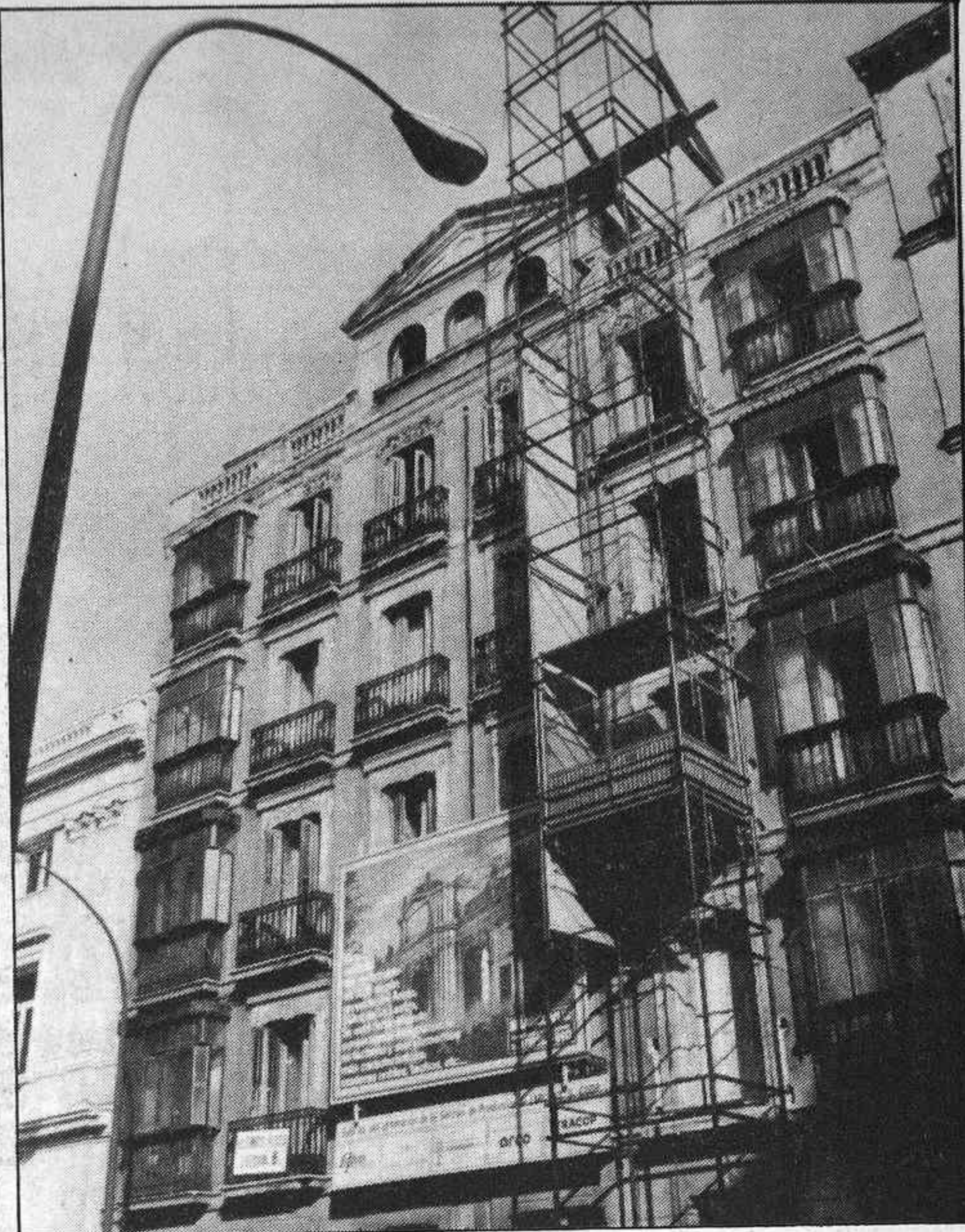
Otro edificio en rehabilitación en el distrito Centro de Madrid.
