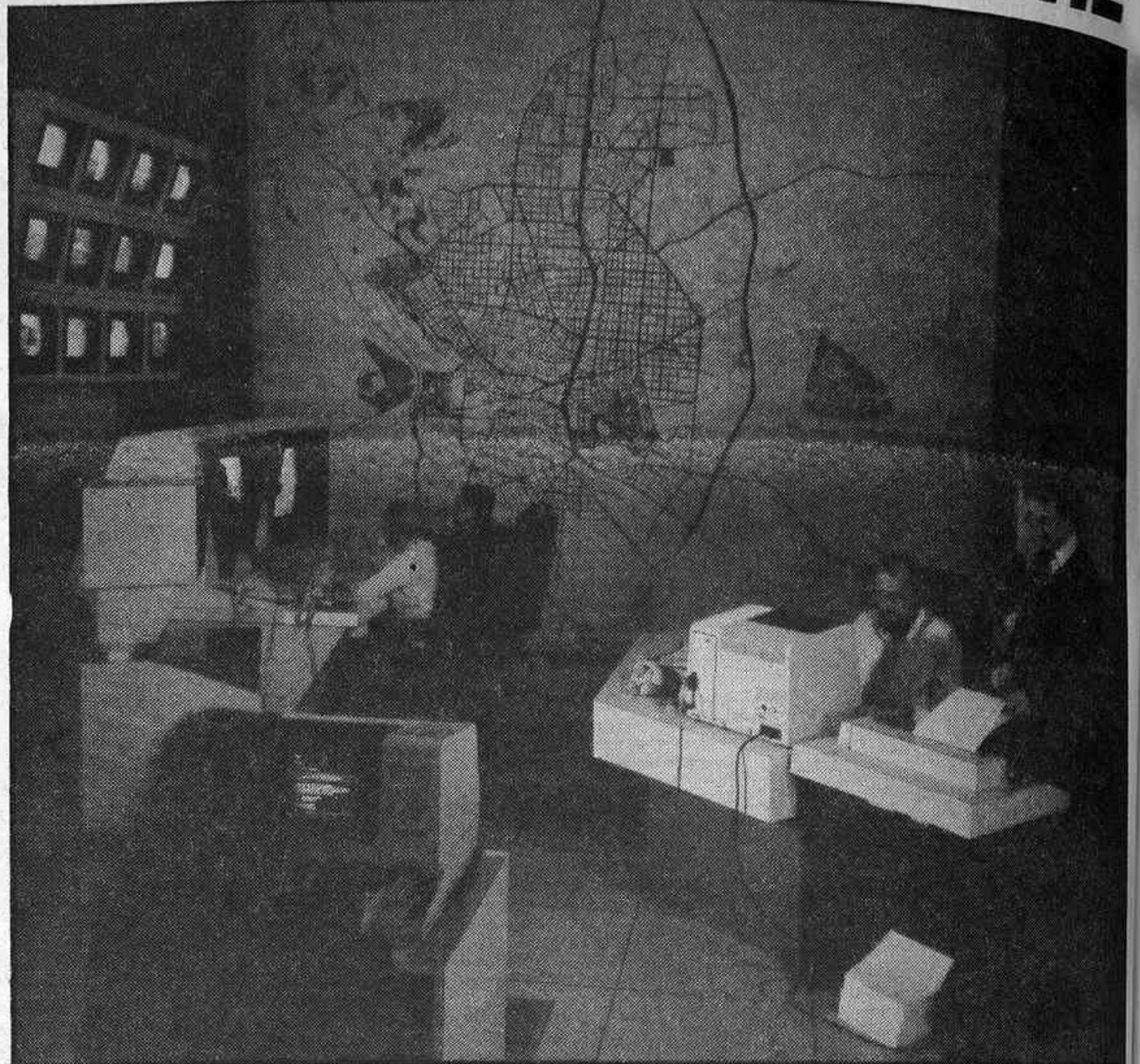
Control central del nuevo Sistema de Control Centralizado de Tráfico, que se ubica en la Casa de la Villa.
