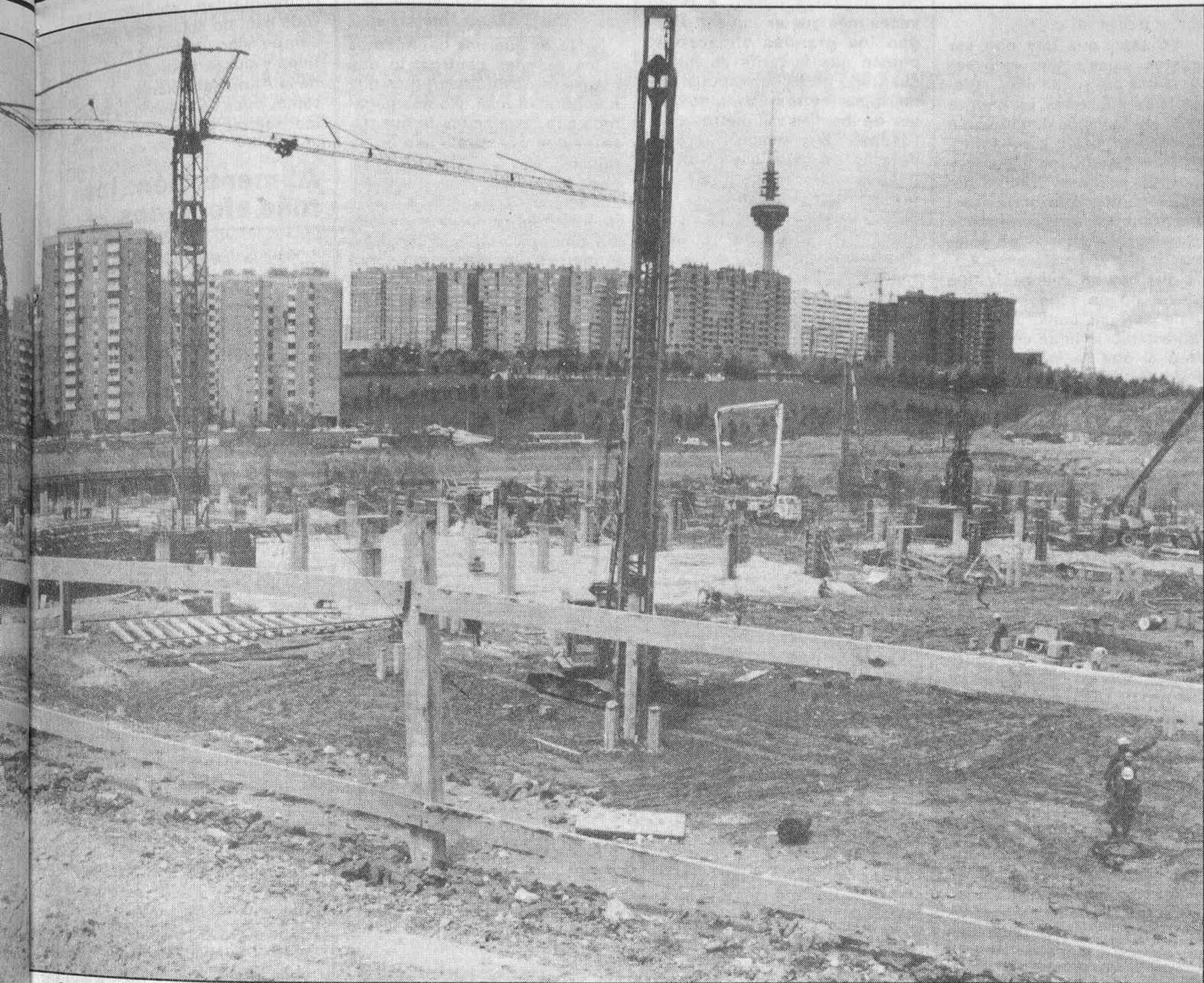
Obras de construcción del hipermercado Alcampo en el barrio de Moratalaz.
