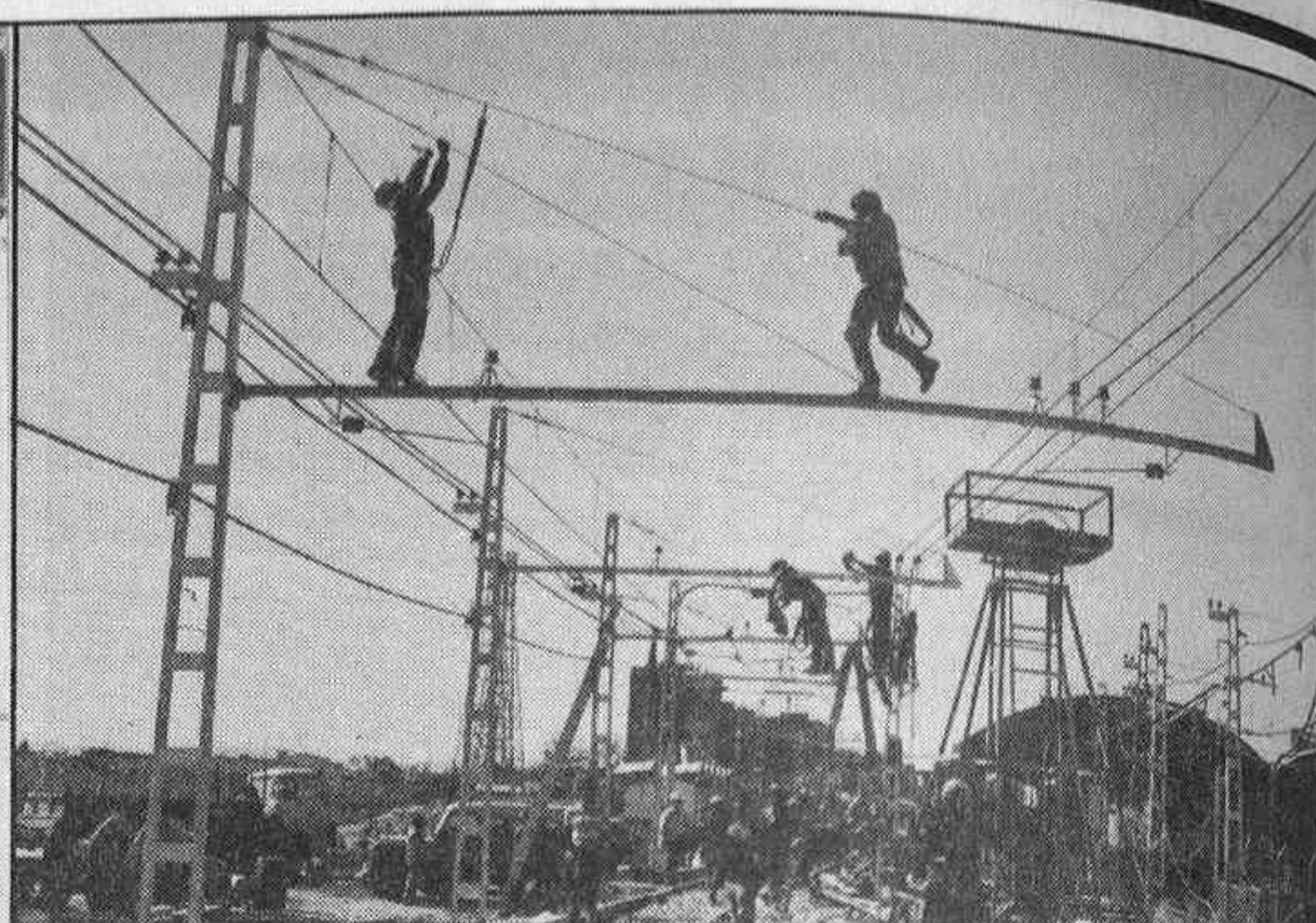
Trabajos en la estación de Aluche. A la izquierda, soldadura de juntas de carril en el nuevo viaducto sur, y a la derecha, modificación del tendido en la línea 5.
