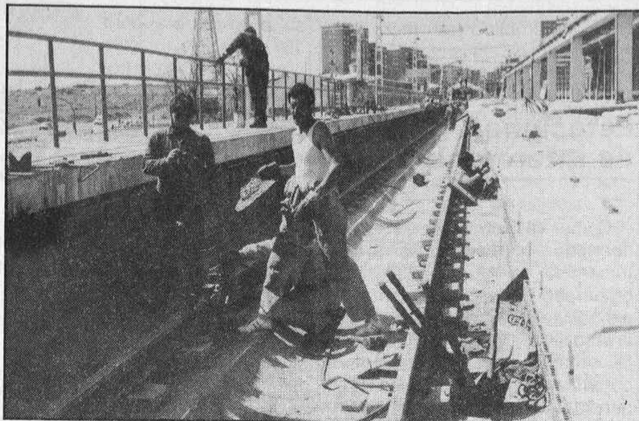
Trabajos en la estación de Aluche. A la izquierda, soldadura de juntas de carril en el nuevo viaducto sur, y a la derecha, modificación del tendido en la línea 5.
