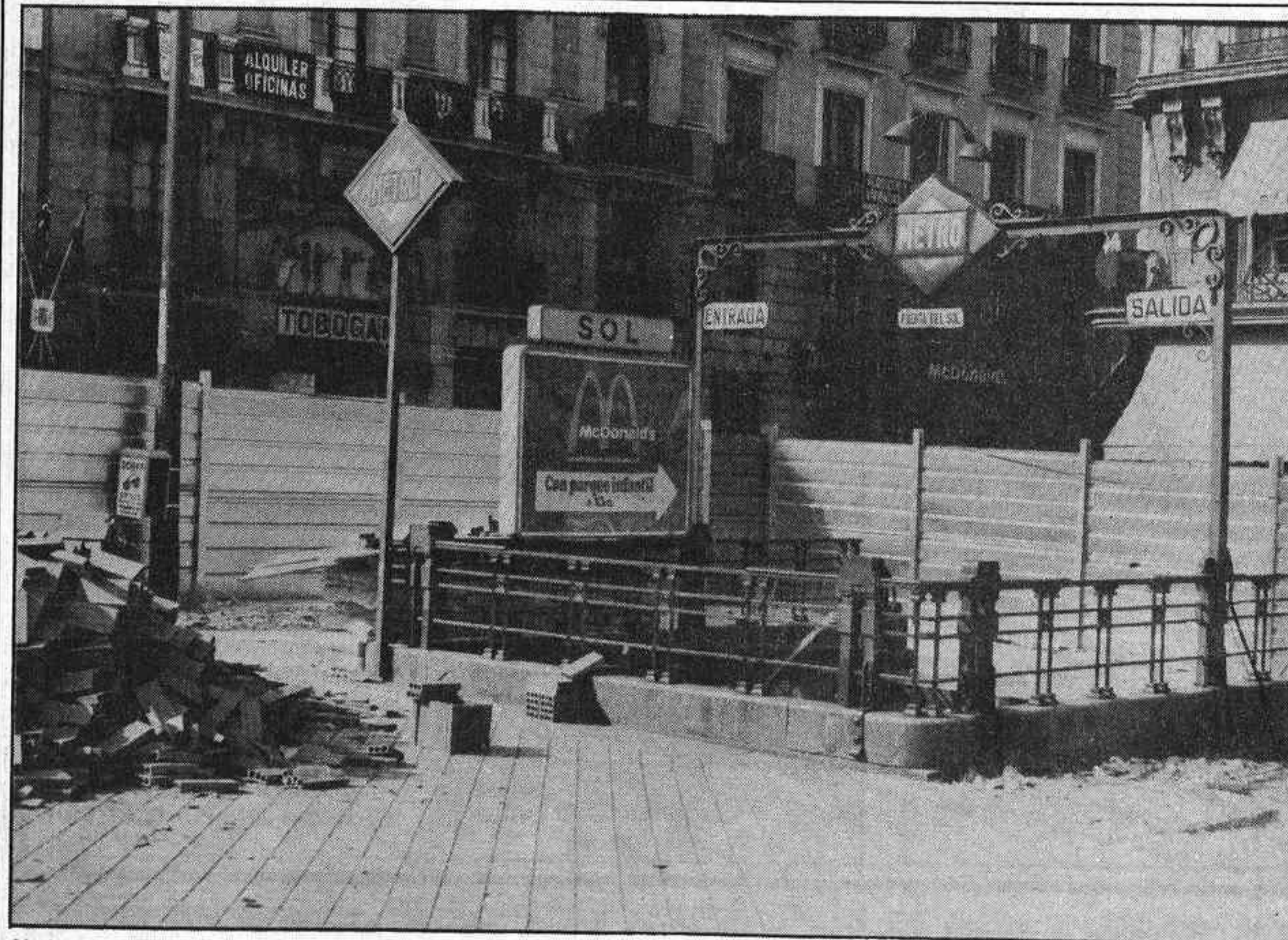
Ya han comenzado las obras de remodelación del Metro en la estación de Sol, con un plazo de ejecución de dieciocho meses.
