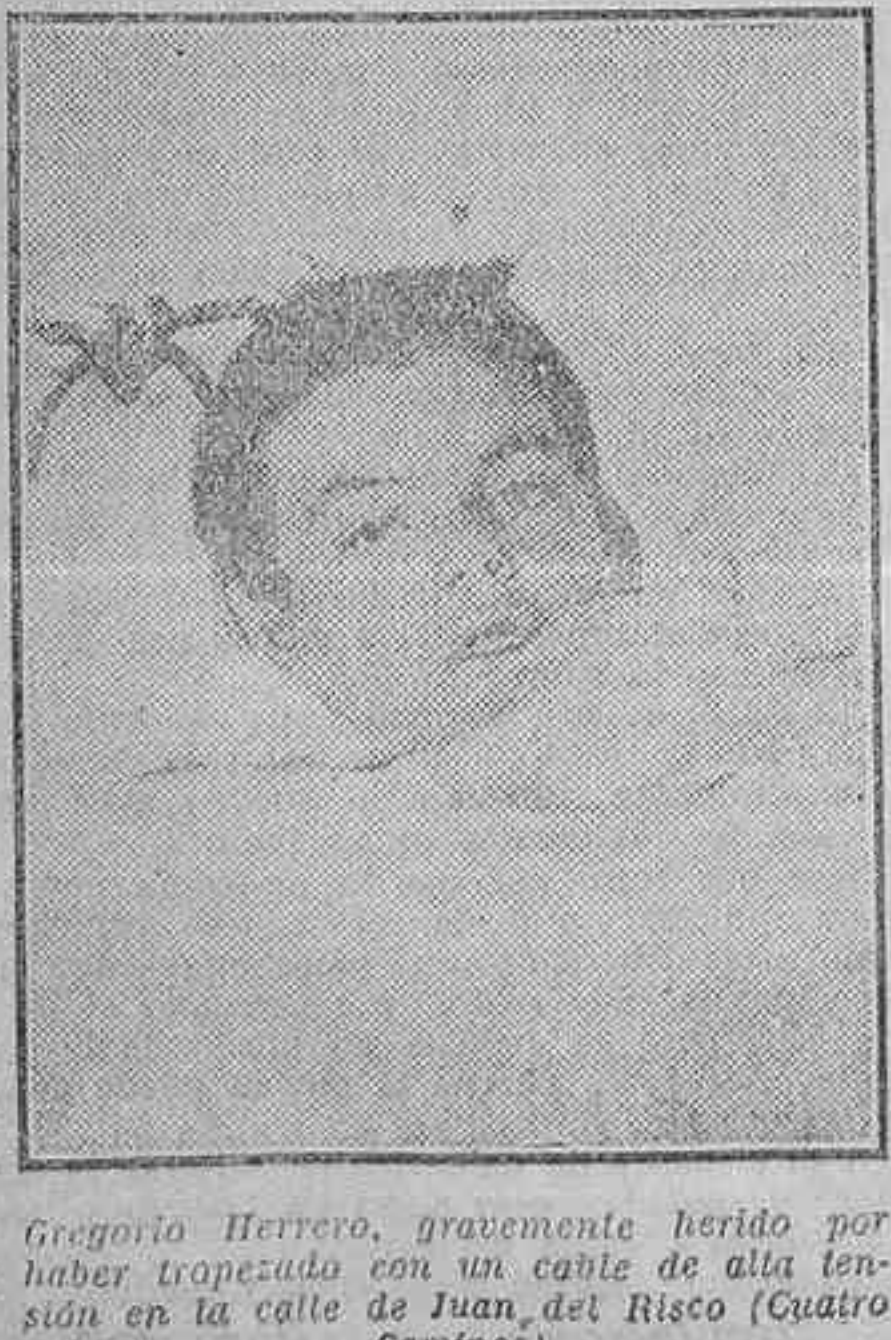
Gregorio Herrera, gravemente herido por haber tropezado con un cable de alta tensión en la calle de Juan del Risco (Cuatro Caminos).
