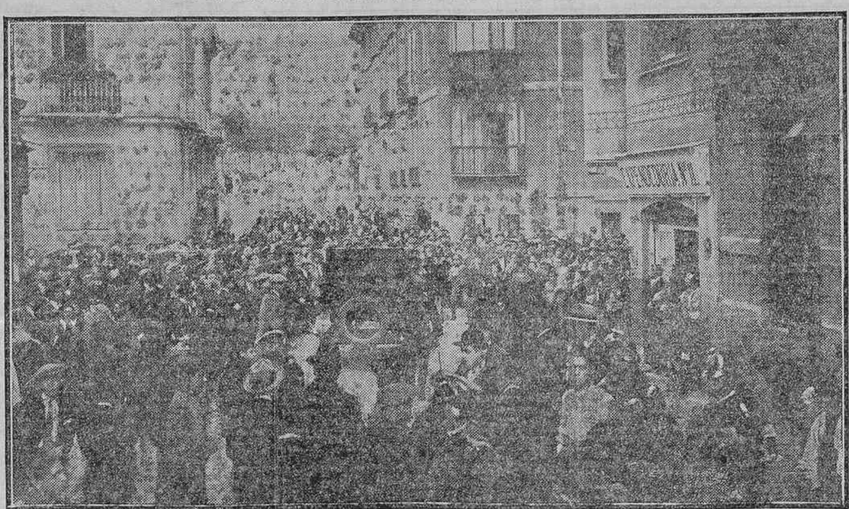
NUMEROSO PUBLICO RODEANDO EN LA CALLE DE SAN MATEO, EL AUTOMOVIL EN QUE FUERON TRASLADADOS A LA CASA DE SOCORRO LOS OBREROS HERIDOS AL PRODUCIRSE UN DESPRENDIMIENTO DE TIERRAS EN UNA ALCANTARILLA
