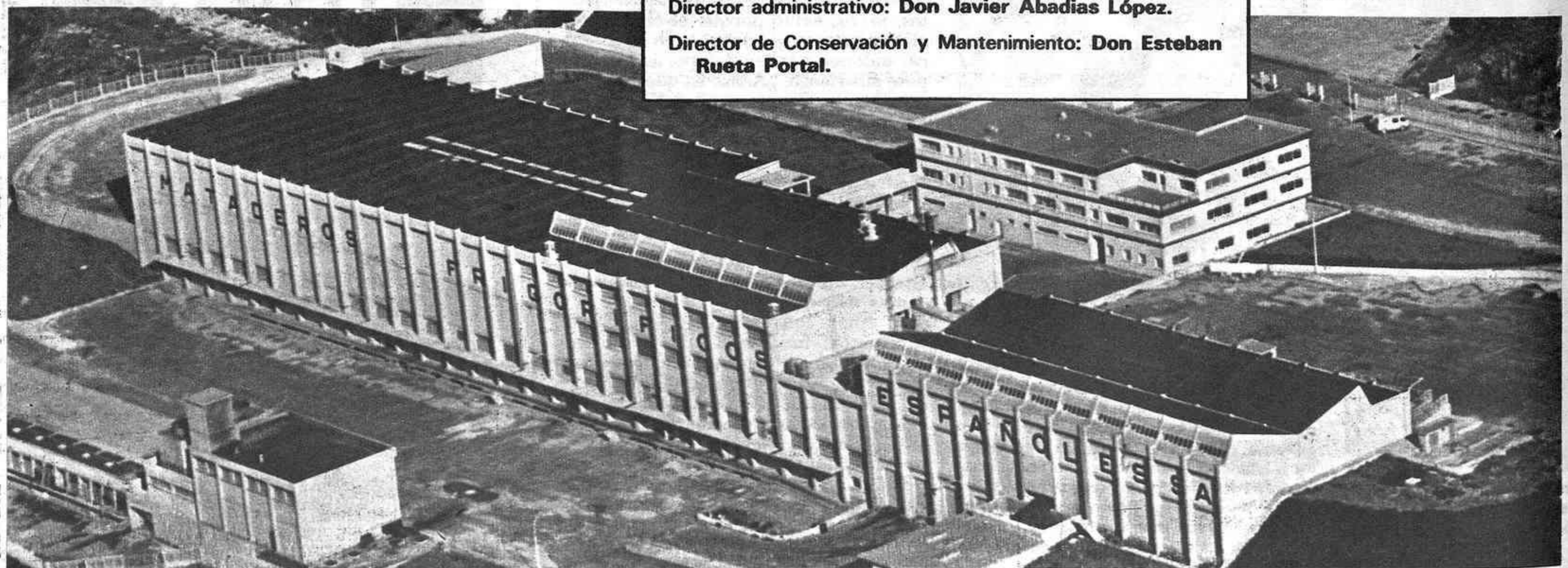
Magnífica vista aérea de las instalaciones de Mataderos Frigoríficos Españoles, S. A. (MAFRISA)
