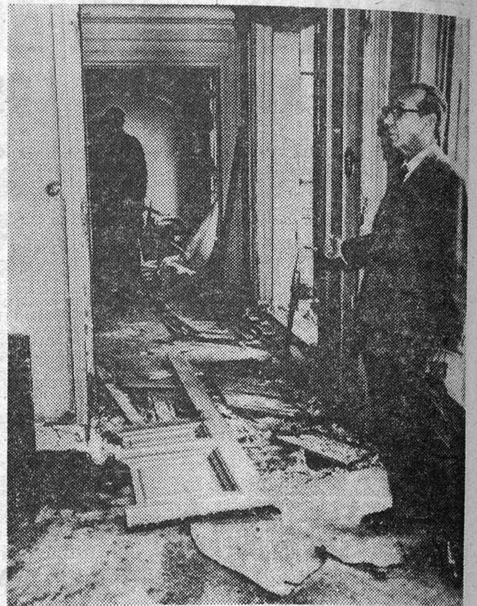
El ex jefe de Gobierno Michel Debré muestra los daños ocasionados en su vivienda al explotar una bomba. (Foto Cifra.)
