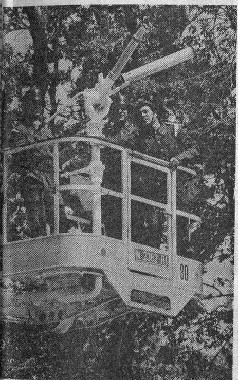
Forma del vehículo articulado, con su mira telescópica y un cañón para la salida del agua
