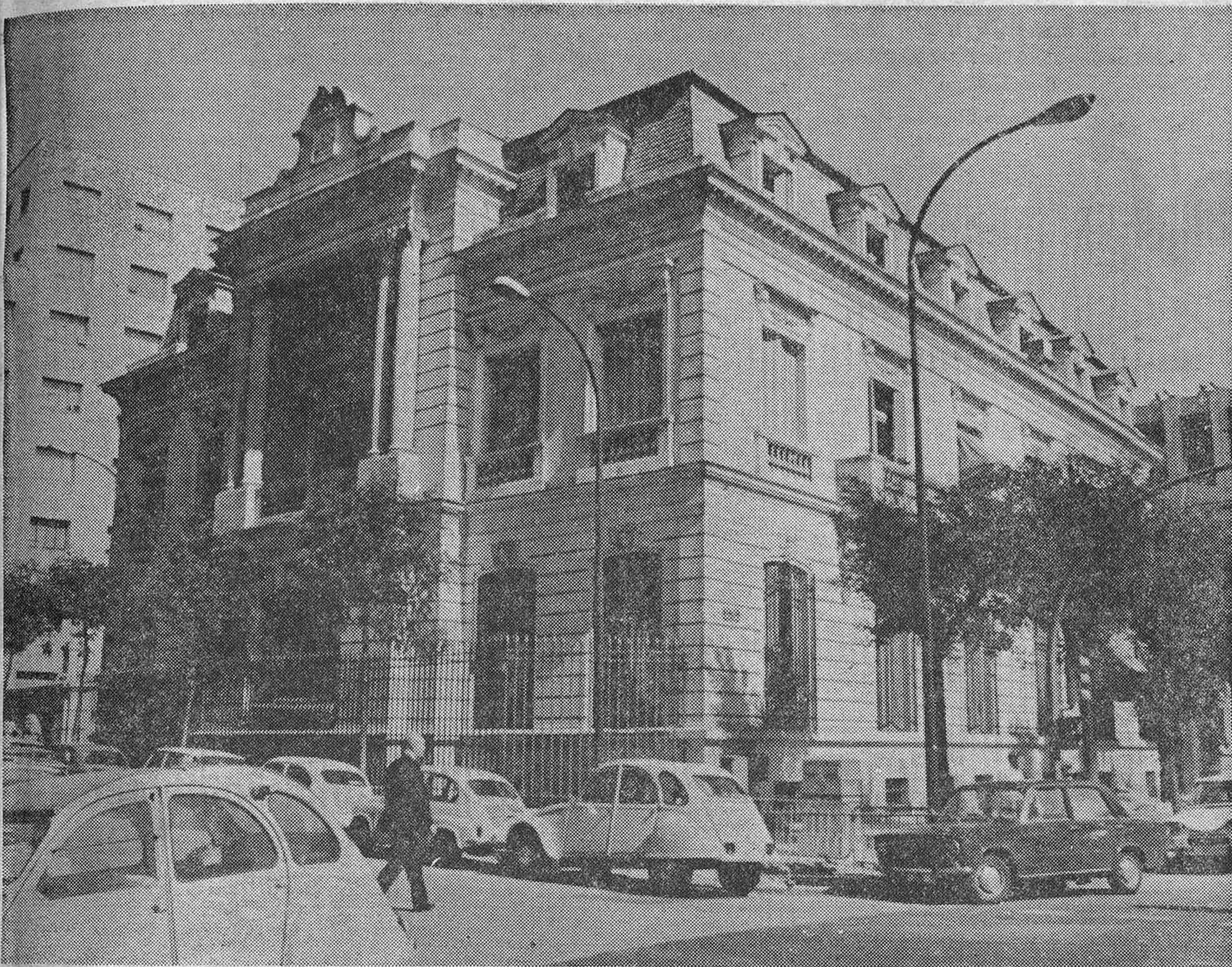
medio de tanto palacio desaparecido, sustituidos por edificios funcionales que han transformado en parte—y en contra—la fisonomía de Madrid, persiste, como un raro plausible ejemplo de respeto a la arquitectura, al empaque y rango de la capital de España, este palacio, que fue residencia de los marqueses de Borghetto y por algún tiempo Embajada de Su Majestad Imperial Hiro-Hito del Japón. Está en la calle de Miguel Angel y hoy es sede de la Diputación Provincial de Madrid, que ha sabido conciliar sus estancias, de proporciones regias, con los elementos funcionales imprescindibles. (Foto Torremocha.)
