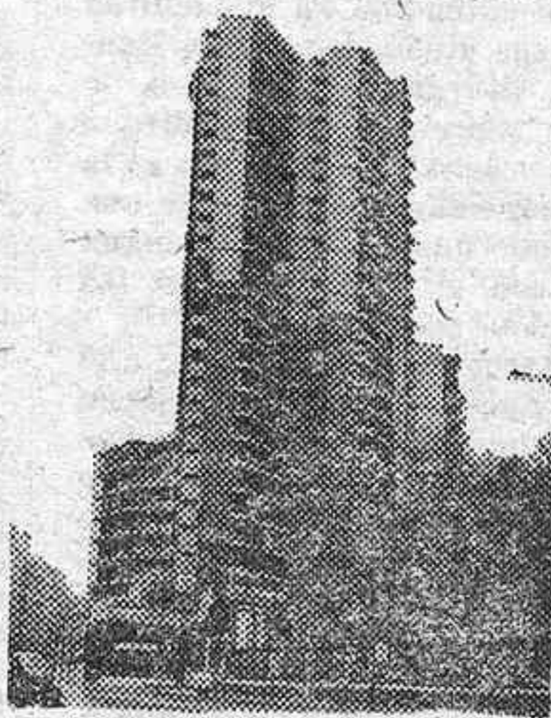
El edificio de la Torre de Valencia, casi totalmente acabado. (Foto Torremocha.)
