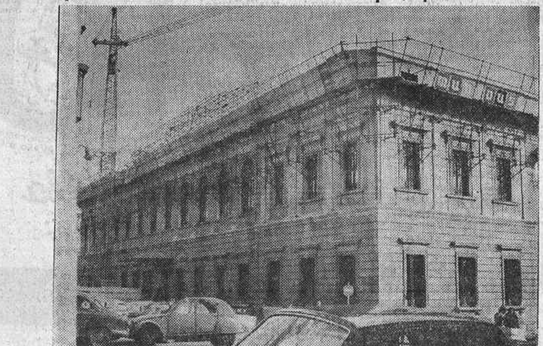
En la parte superior del edificio de las Cortes ha sido montado un andamiaje, y en la calle de Florida Blanca ha sido colocada una gran grúa para facilitar el acarreo de materiales.
