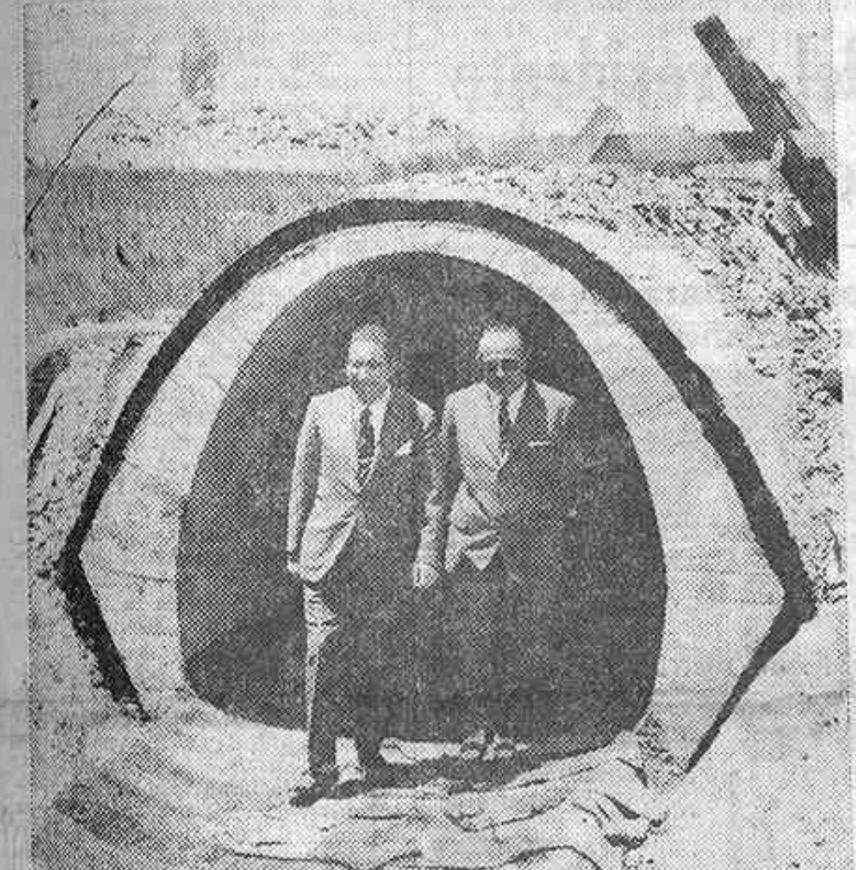
El ministro de Obras Públicas, don Federico Silva Muñoz, y el alcalde de Madrid, don Carlos Arias Navarro, visitan las obras del plan de urgencia para el abastecimiento de aguas a la capital. (Foto cedida por el laboratorio fotográfico del ministerio de Obras Públicas.)
