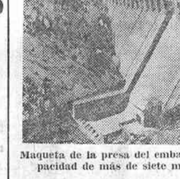
Maqueta de la presa del embalse de La Jarosa, que tendrá una capacidad de más de siete millones de metros cúbicos de agua
