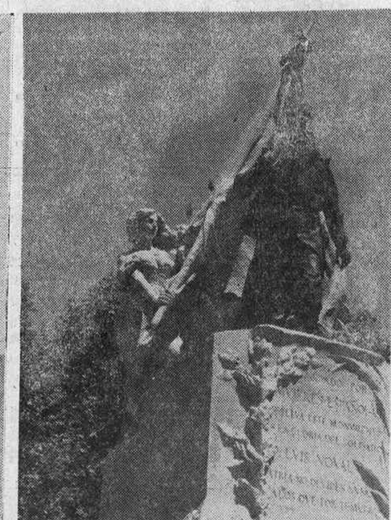
El monumento, restaurado, del cabo Noval parece distinto, una vez arreglados los desperfectos
