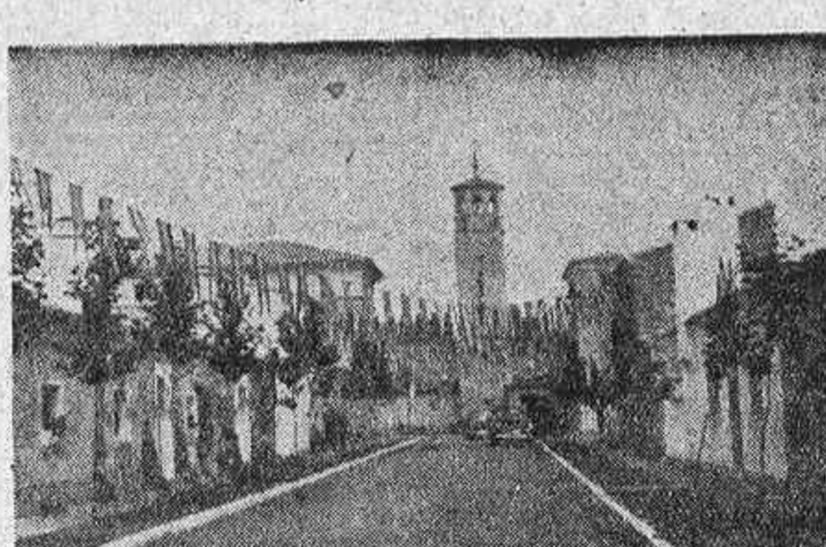
El Templo, nuevo pueblo para colonos, construido en Huesca.
