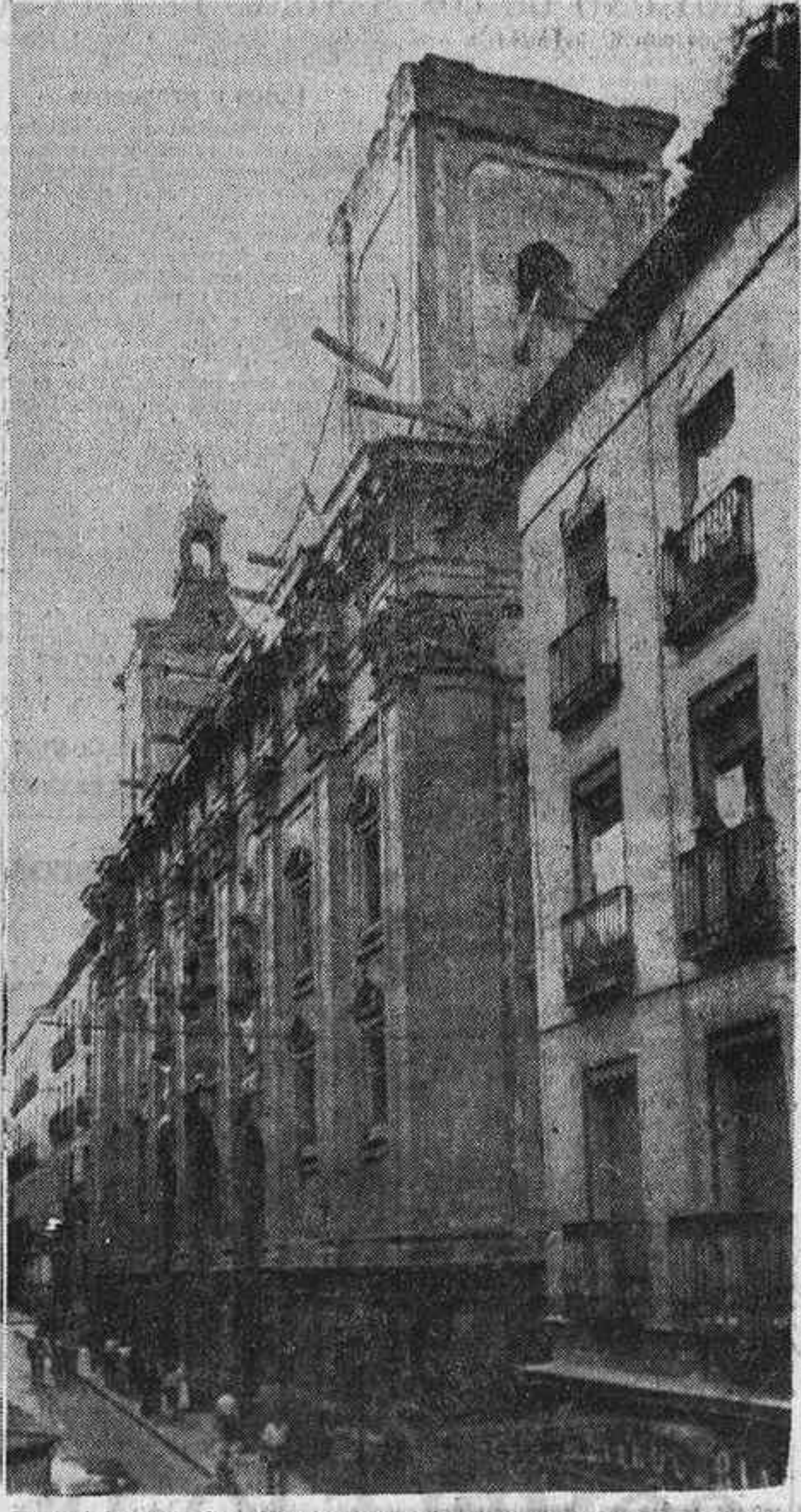
De la iglesia de San Cayetano sólo había quedado en pie la fachada, una de las muestras más típicas de la arquitectura churriguera. Reconstruida la cúpula y reparados los pilares que la dinamita había destruido, poco bastará para abrir de nuevo al culto la antigua parroquia de la calle de Embajadores. (Foto Portillo.)
