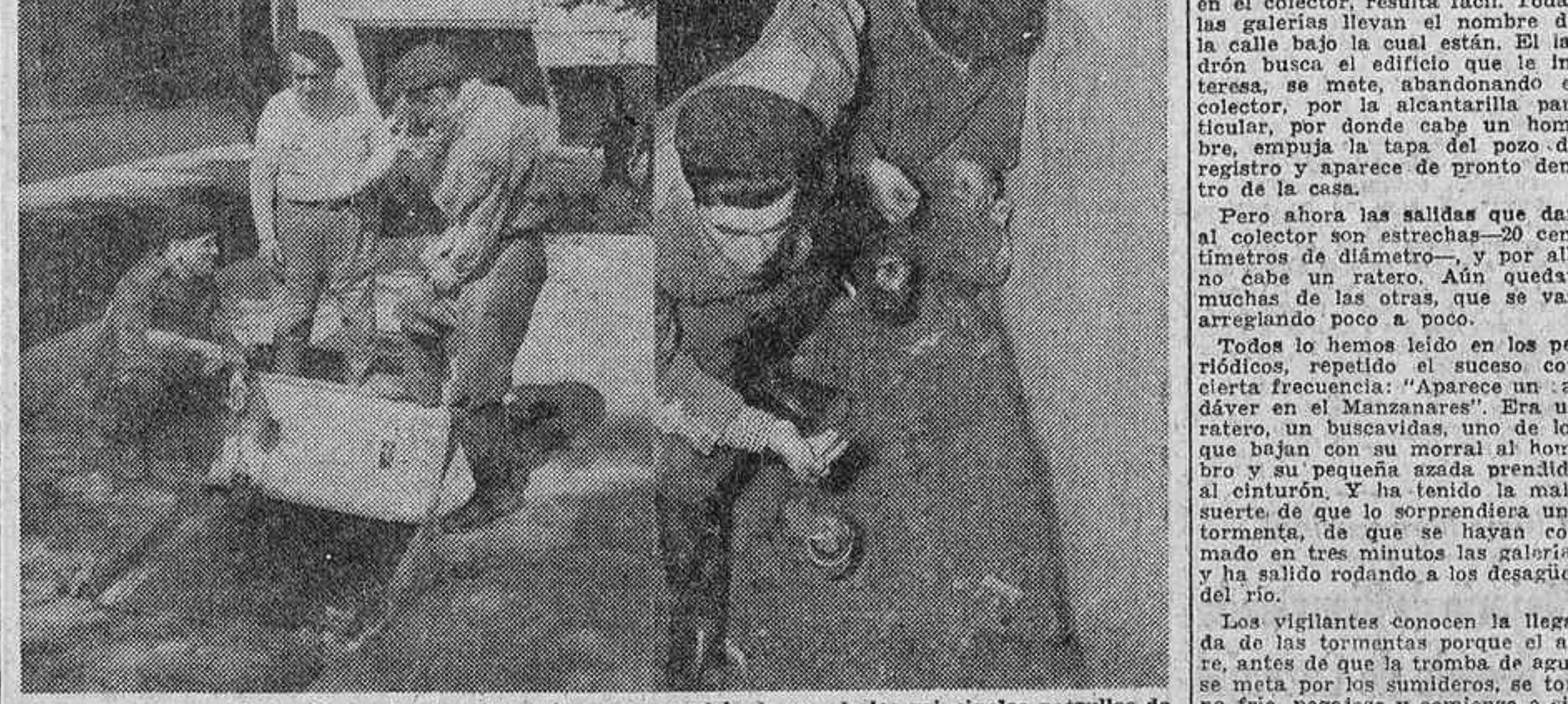
Aparecen en el grabado dos momentos diferentes en el servicio de una de las principales patrullas de vigilancia del alcantarillado de Madrid. A la izquierda, Jerónimo Jiménez, (en mangas de camisa y acompañado por un par de empleados) se dispone a descender a la profundidad. La boca está ya abierta. A la derecha, con los candiles de carburo en la mano, la cuadrilla comienza a bajar. Veinte metros más adelante se encontrará con un colector. (Fotos Portillo.)
