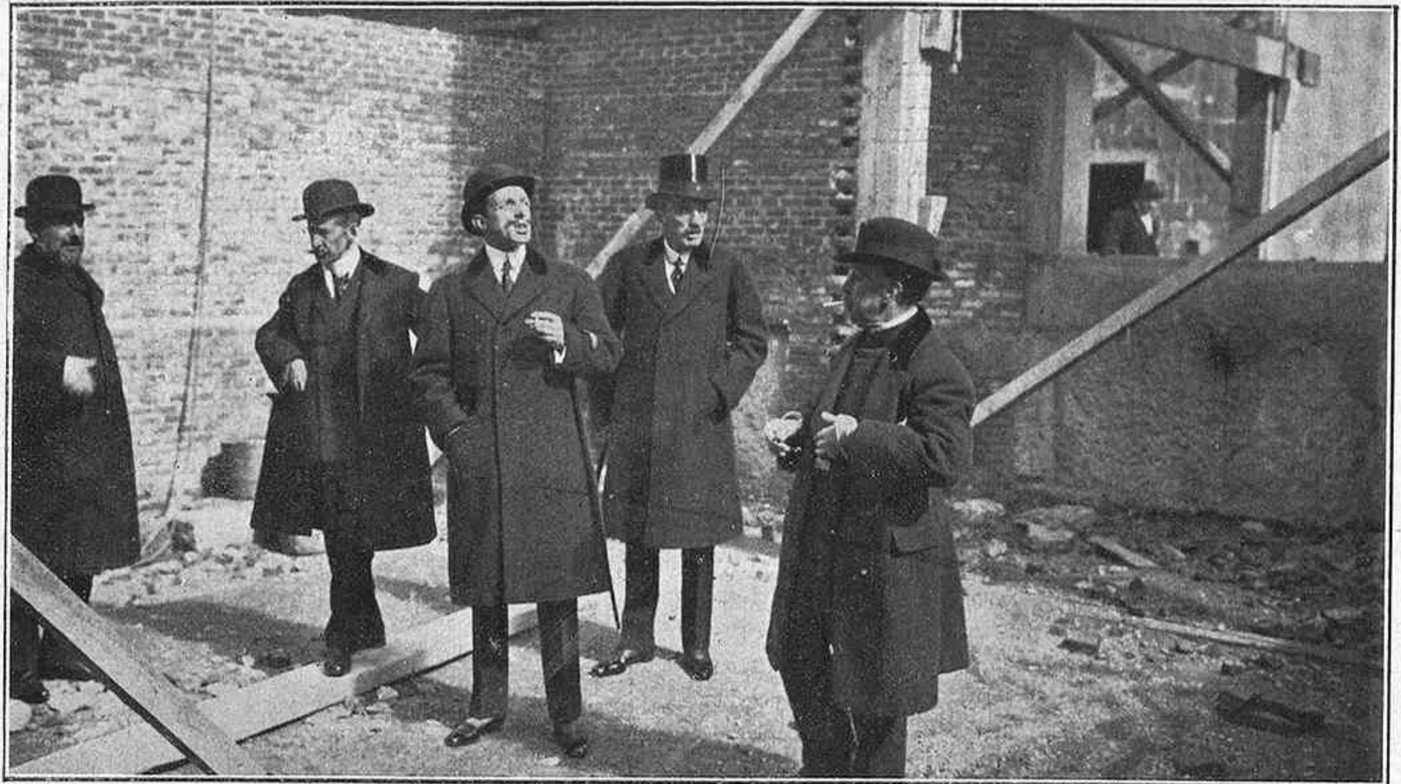
Madrid. — S. M. el Rey visitando las obras que se están efectuando en el Museo del Prado
