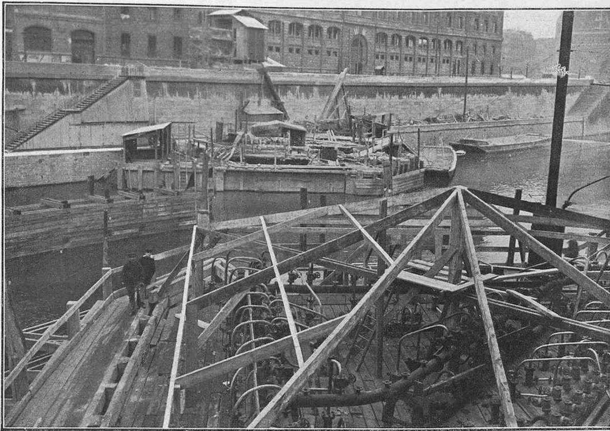
Vista general de las obras para consolidar el subsuelo fluvial, operación que se efectúa por medio de máquinas con motor de amoníaco que permiten perforar el suelo congelado
