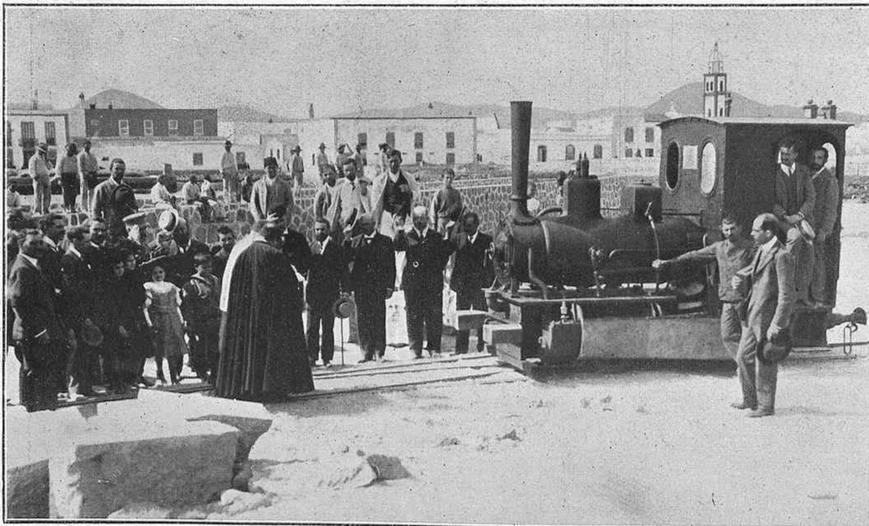
Arrecife de Lanzarote (Canarias) Bendición de la locomotora destinada á las obras del puerto
