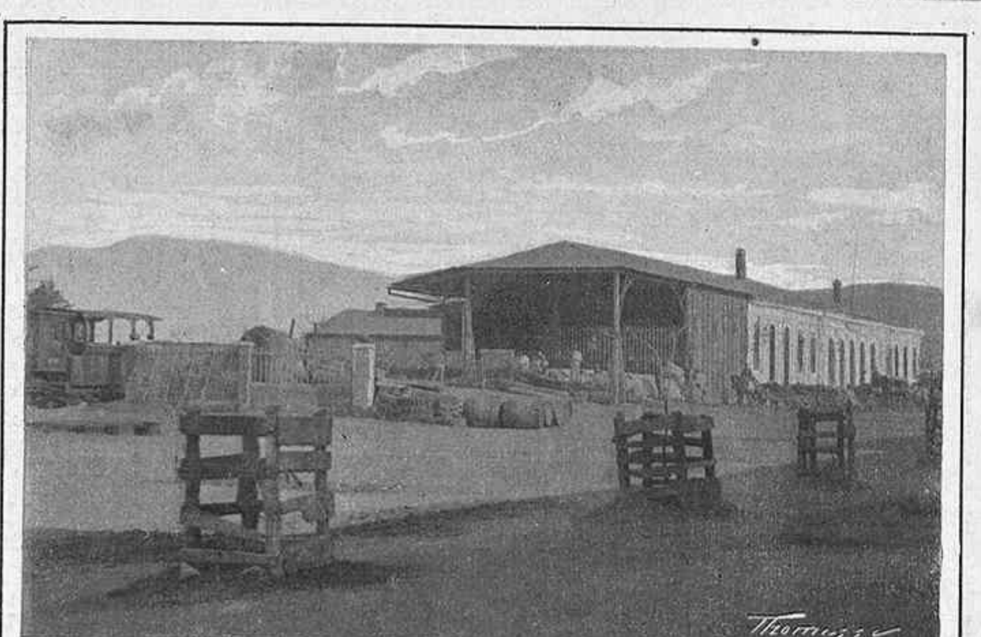
ESTACION DEL FERROCARRIL DE SABANILLA Y MAROTO
