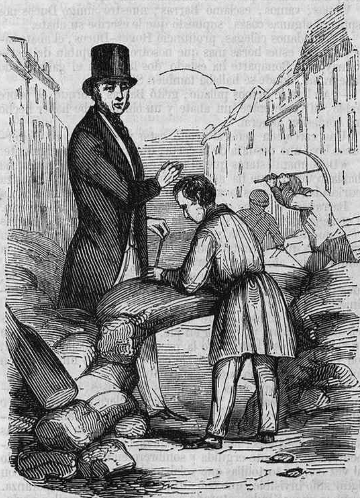
El puente de arena.
