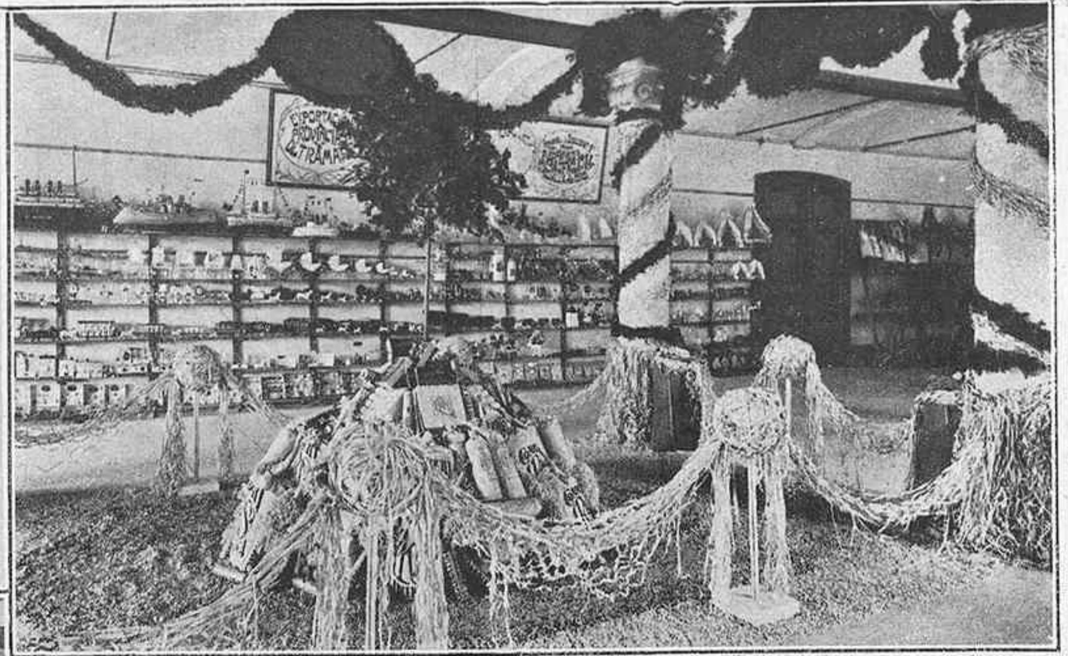
Vista de algunas instalaciones
