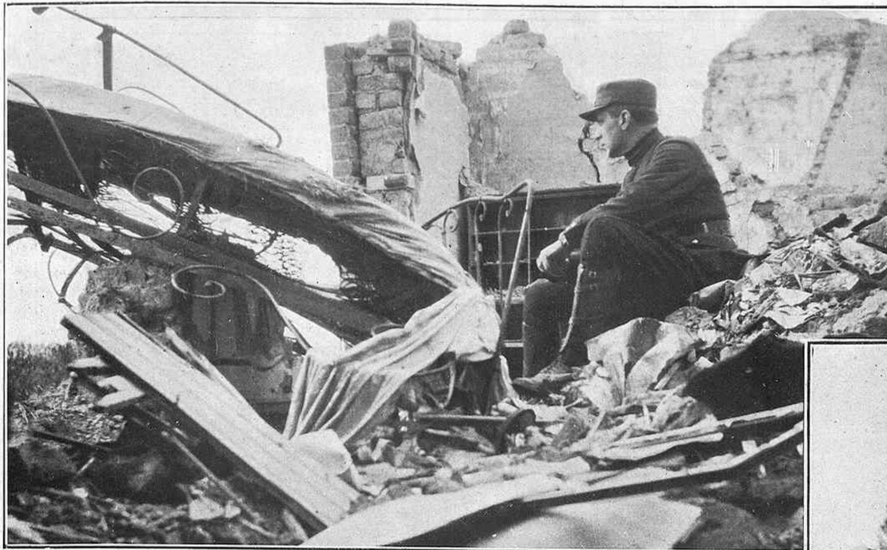
Soldado belga de la Cruz Roja entre las ruinas de su vivienda. Al salir de ella por la mañana, la casa se hallaba en buen estado, pero al volver por la noche la encontró derruida por efecto del bombardeo
