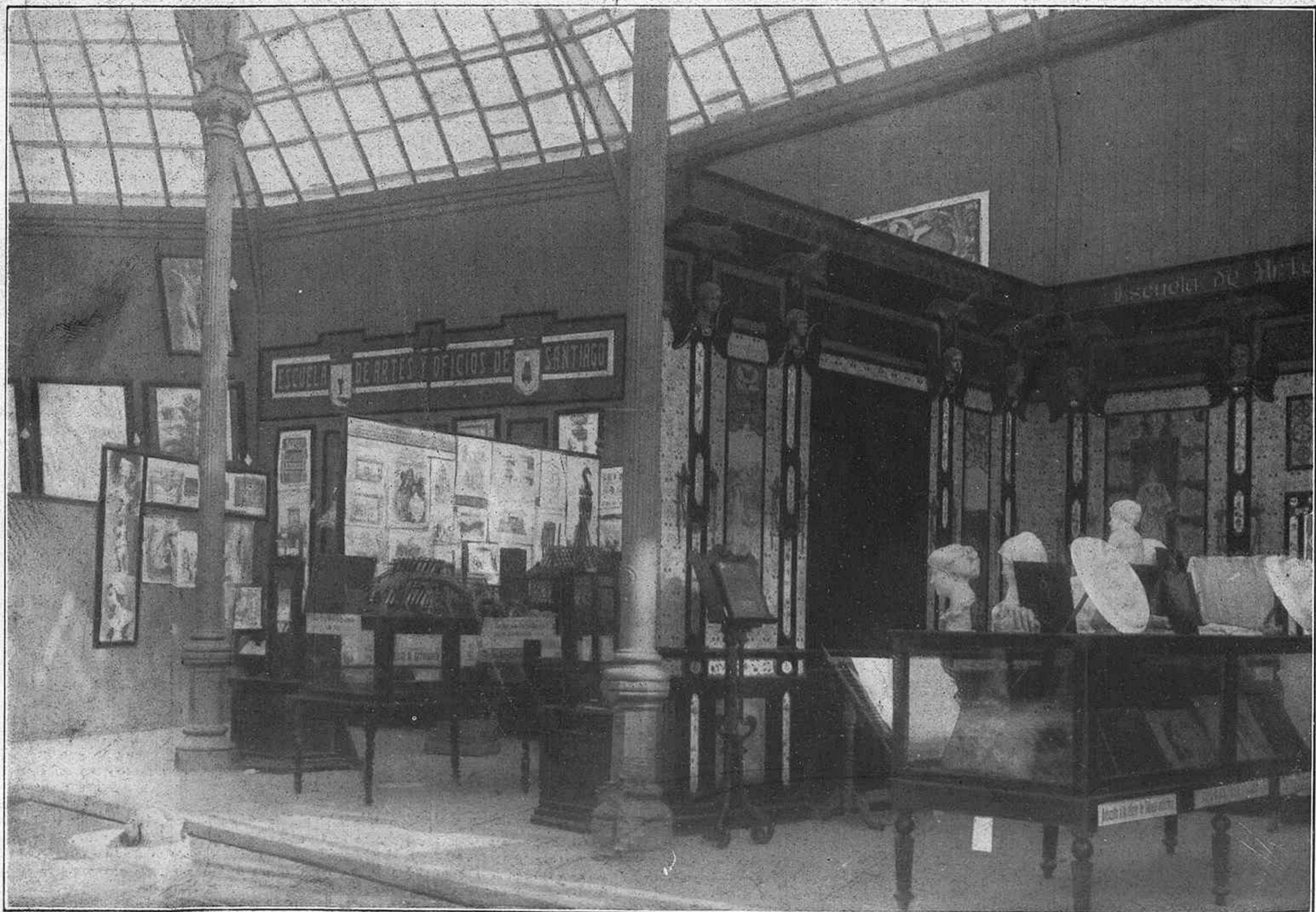
Instalación de las Escuelas de Artes y Oficios de Valladolid y Santiago
