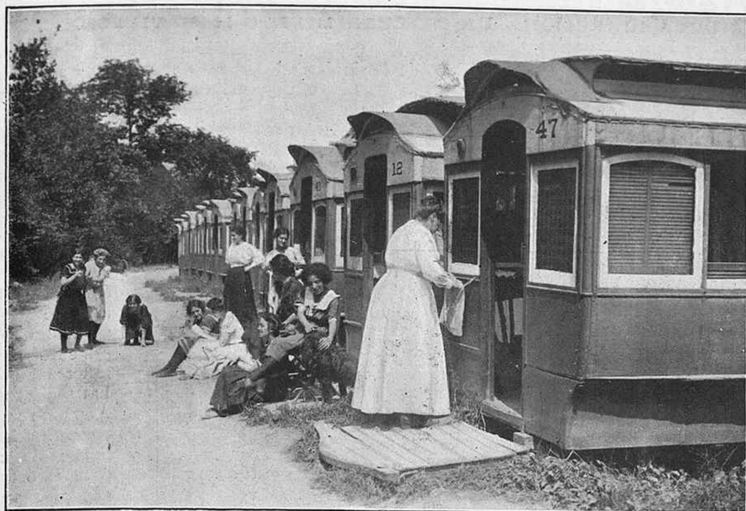
Vista del campamento de veraneo
