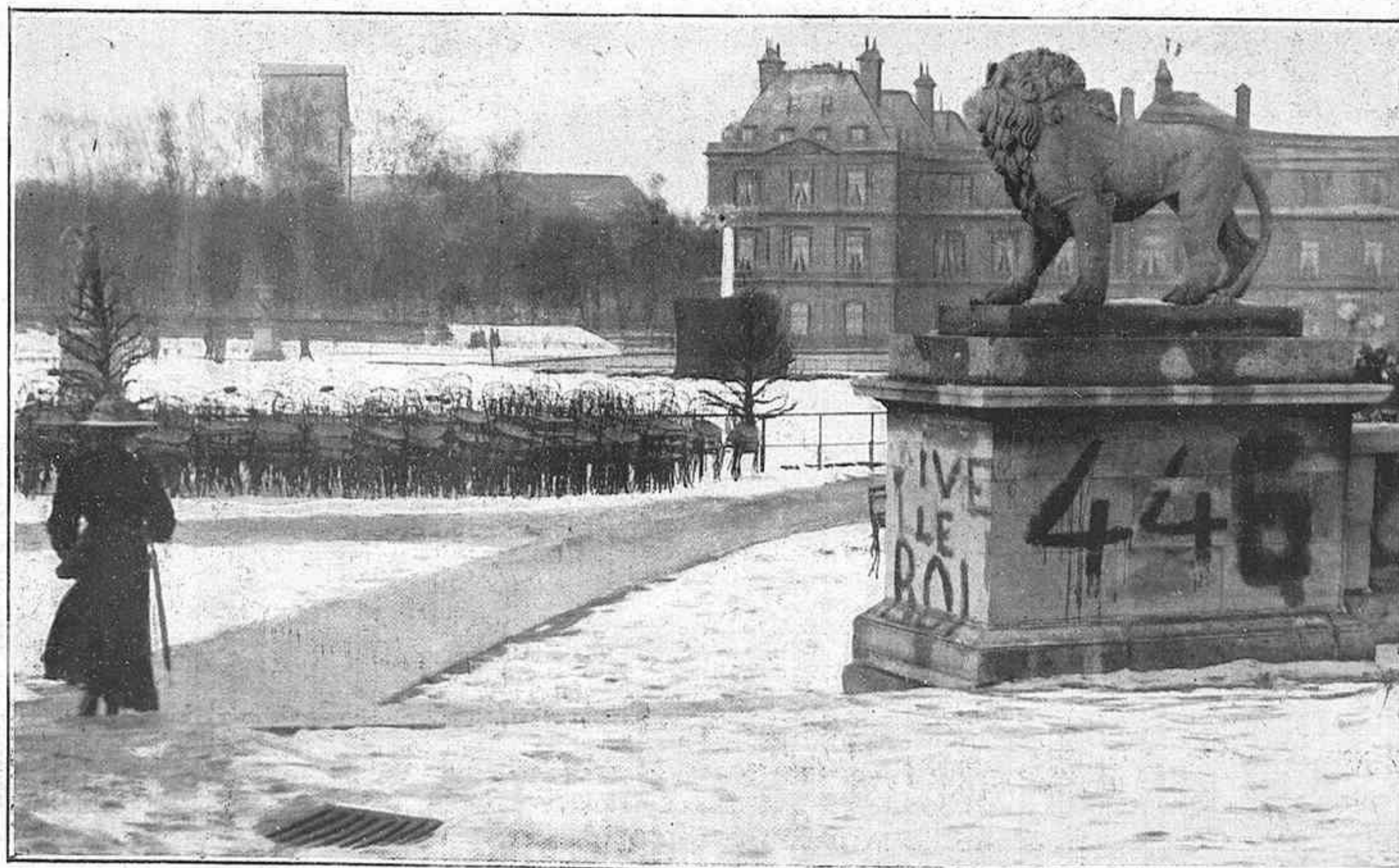
En los Jardines del Luxemburgo. Daños causados en varias estatuas
