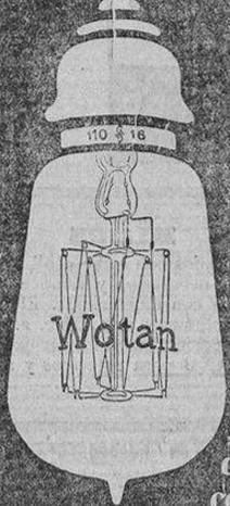
La Primera lámpara del mundo construída con filamento estrado
