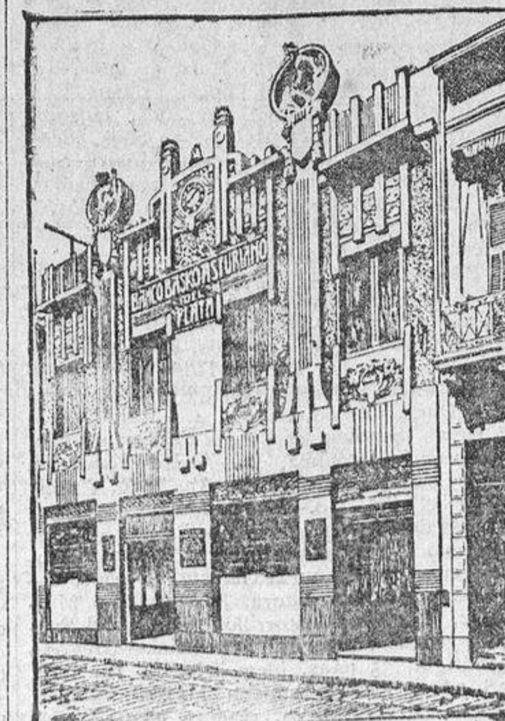
EDIFICIO DEL BANCO
