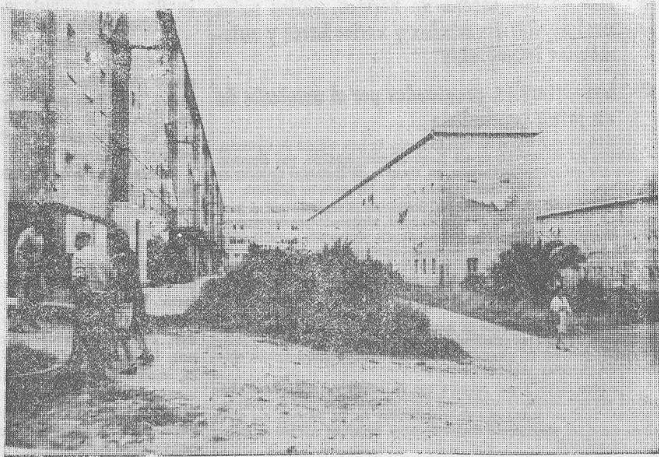
Un aspecto de las Viviendas Protegidas de El Ferrol, con las zarzas invadiendo la calzada
