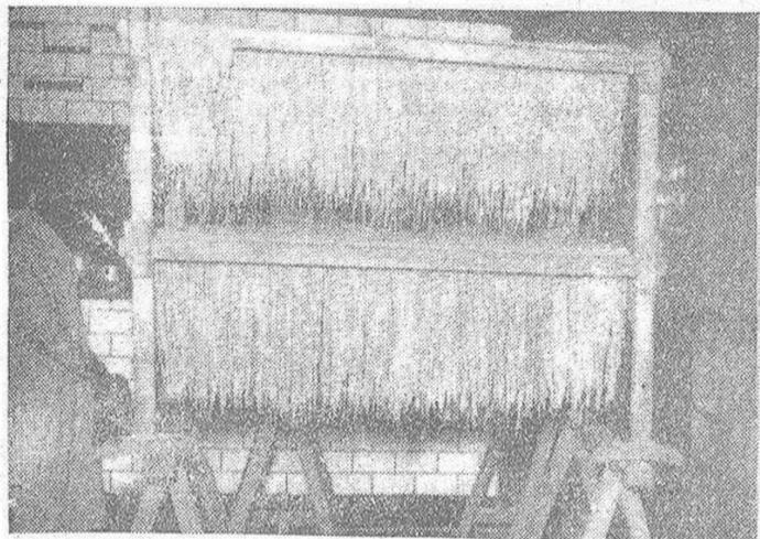
En el horno de la Prisión y en una pequeña máquina especial, se fabrica pasta para sopa a razón de unos 20 kilos por hora de trabajo. Con la producción de esta fábrica, que está al cargo de dos reclusos, se atiende a las necesidades de la Prisión y a las de la región. En el grabado puede verse el fideo recién salido de la máquina, colocado en el tendedero para su secado, y, al fondo, el horno en que se cuece el pan.
