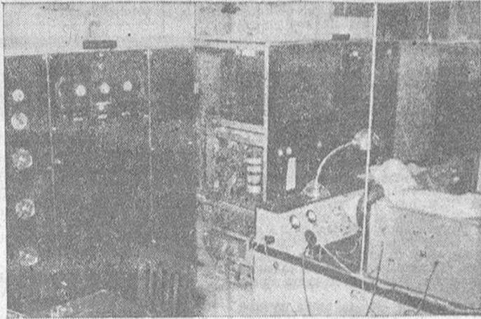
Equipos emisores de la Estación Radiotelegráfica Costera, de onda normal, M11, en el centro; equipo de socorro MT5, a la derecha, para casos de sustitución; y equipo de extracorta, con cuatro bandas MT3, de gran alcance, a la izquierda
